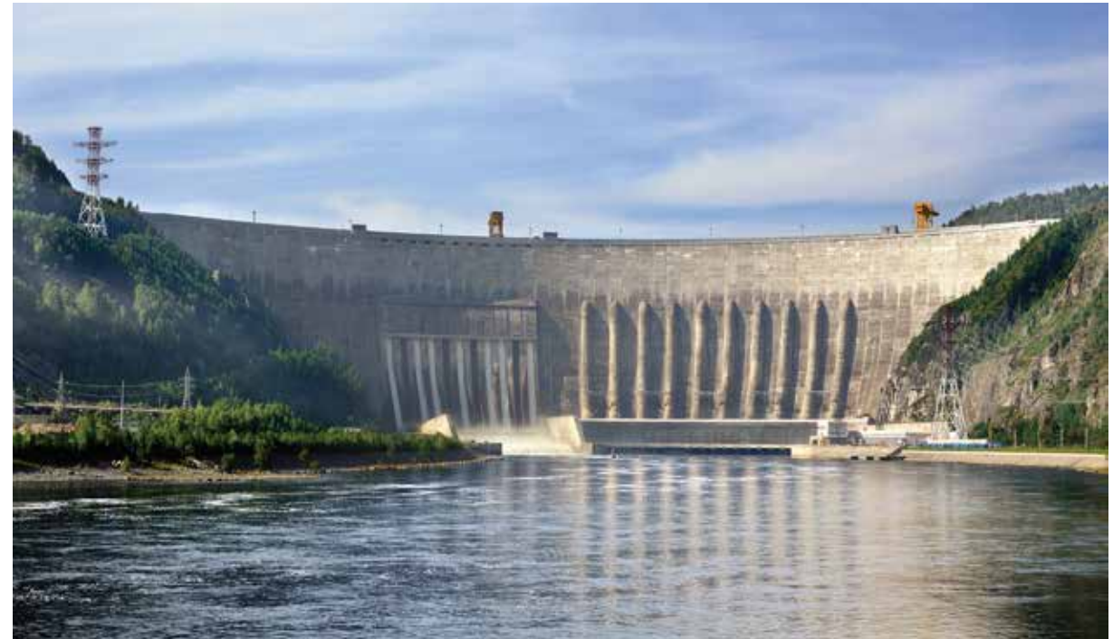
Плотина, Саяношуйская ГЭС на реке Енисей в Сибири, Россия
