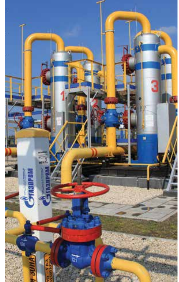
Газораспределительная станция №22 в Ульяновской области
