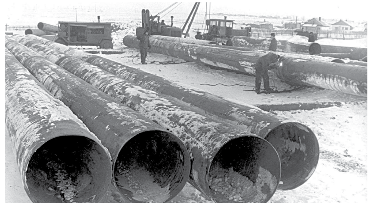
Строительство нефтепровода Дружба-2
