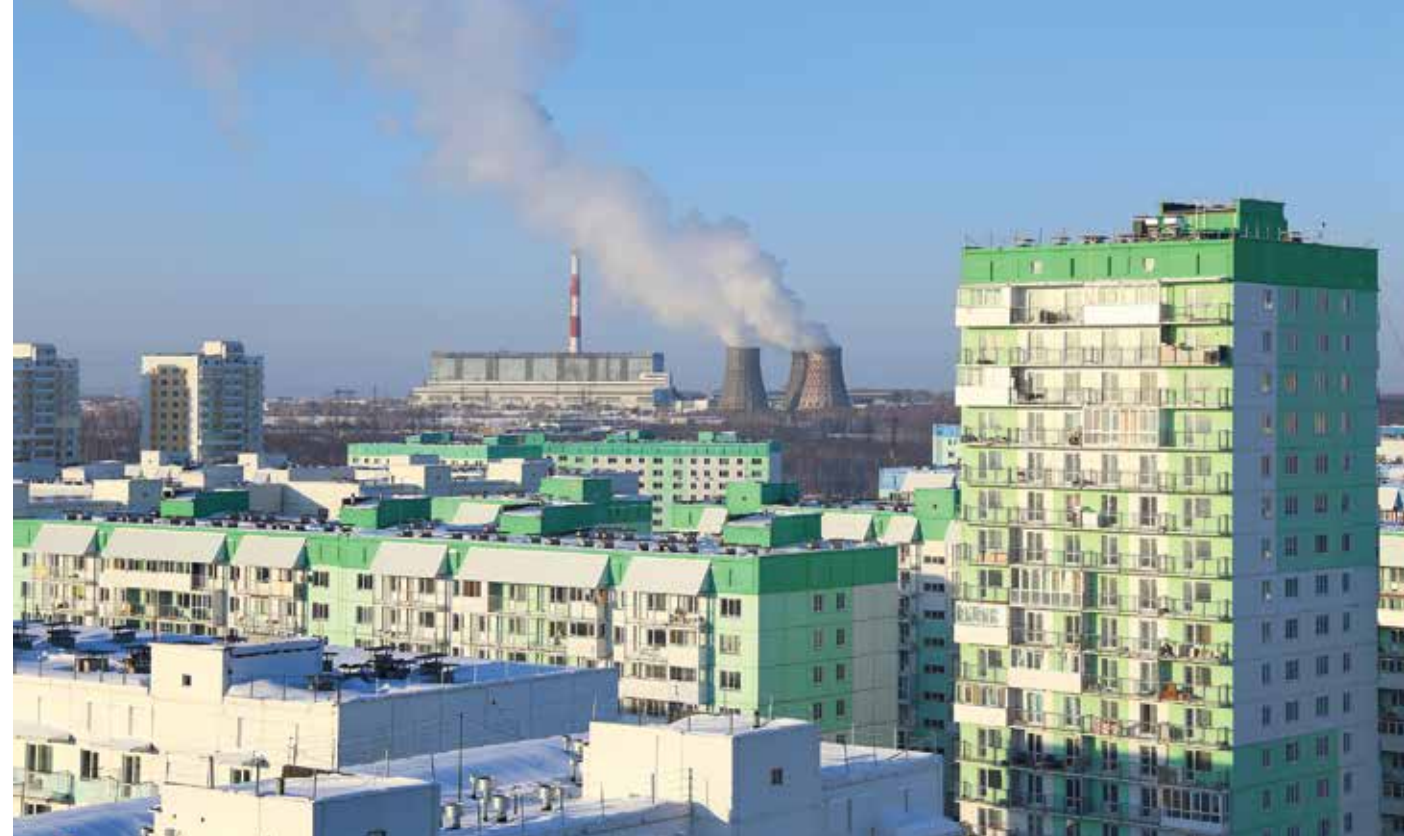
ТЭЦ в Новосибирске
