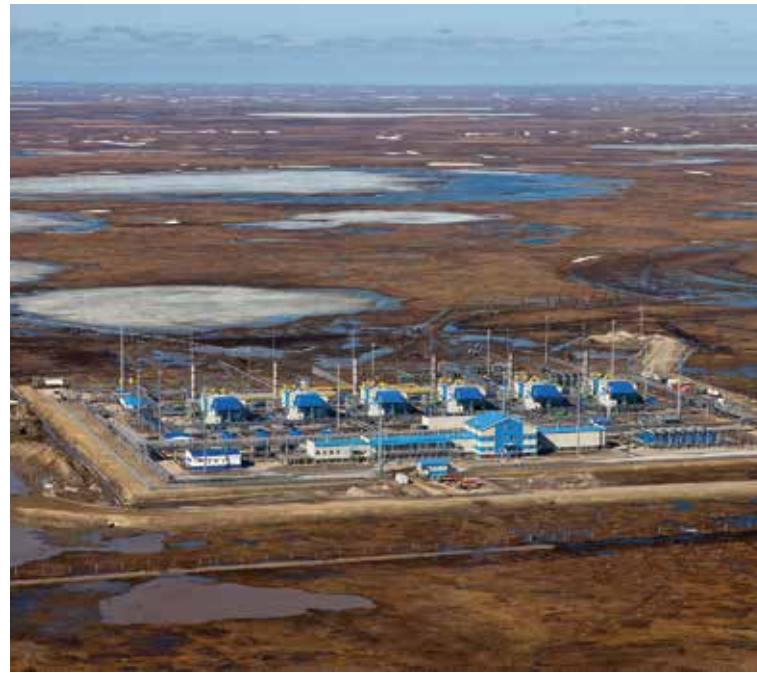
Компрессорная станция «Байдарацкая» Источник: Газпром
