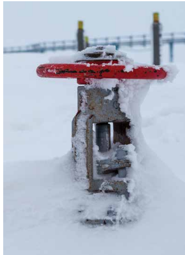
Сила Ямала Источник: Газпром
