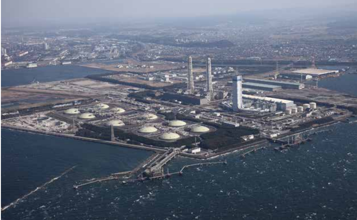
Регазификационный терминал TEPCO LNG, Япония Источник: power-eng.com
