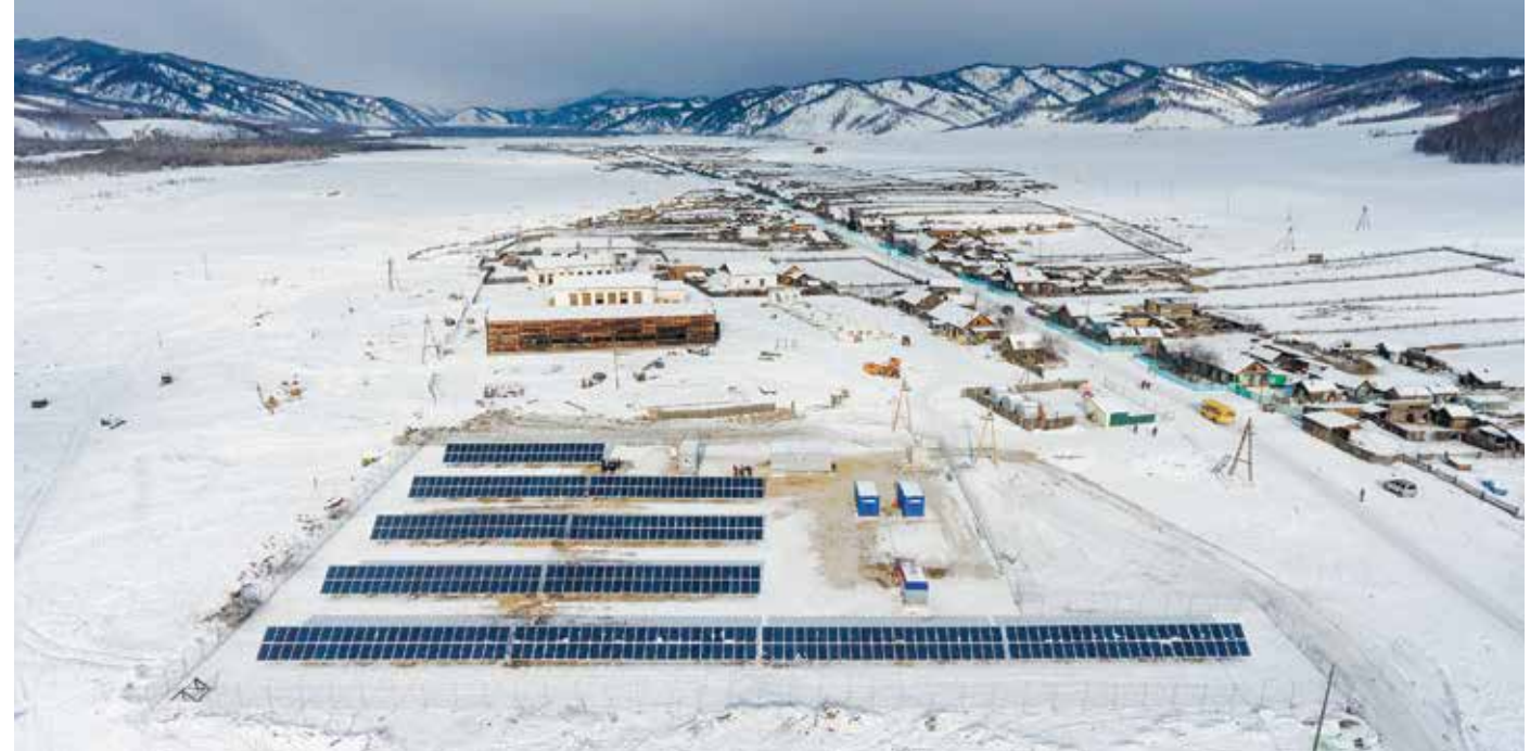
Солнечная электростанция АГЭУ в Забайкальском крае
