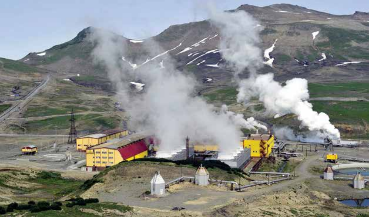
Мутновская геотермальная станция
