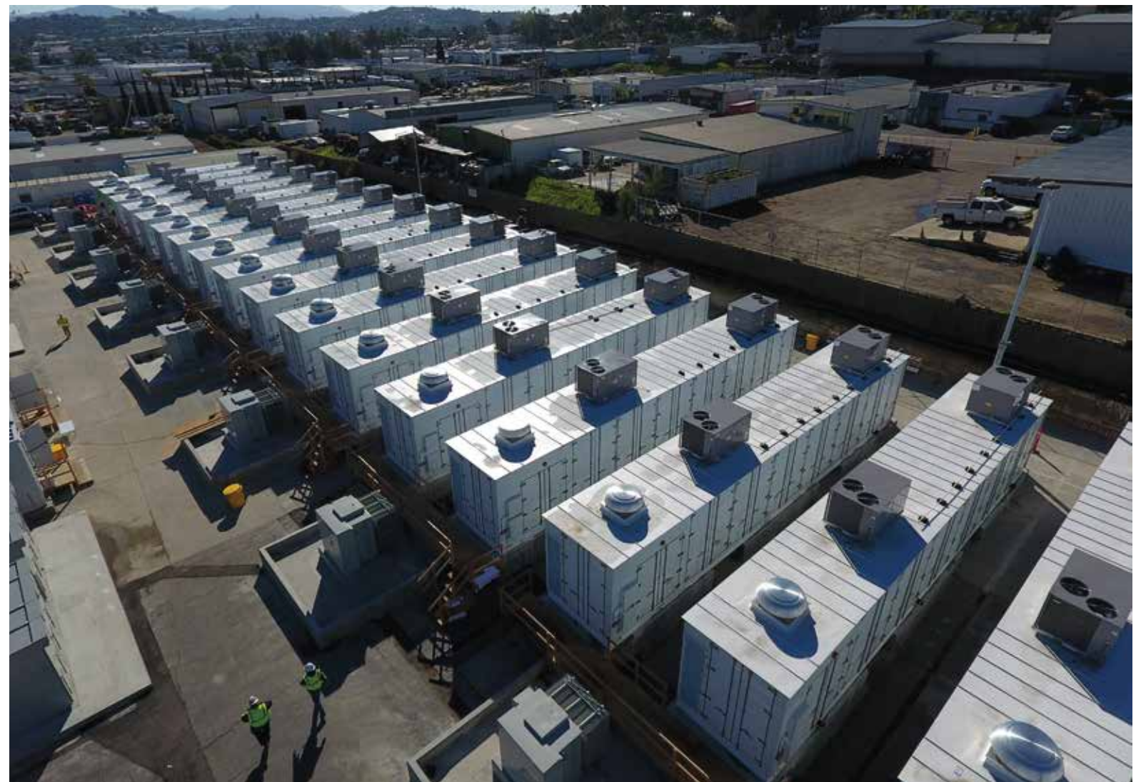
Рис. 3. Система накопления в Сан-Диего 30 МВт, емкость 120 МВт·ч
