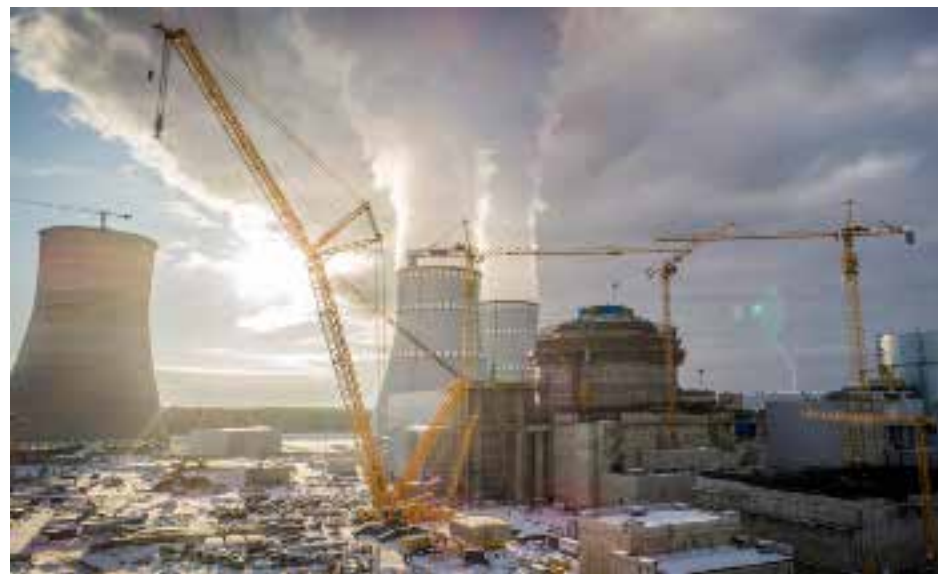
Ленинградская АЭС-2 Источник: atomic-energy.ru
