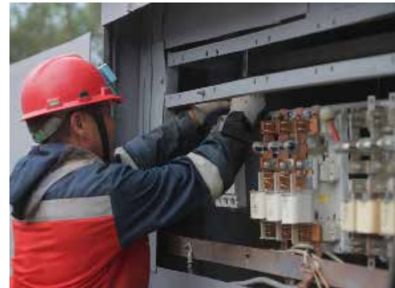
Ремонт на электростанции Источник: «МРСК Сибири»
