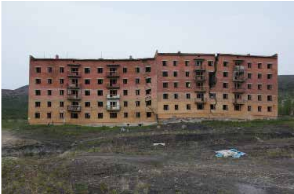
Таяние грунта приводит к проседанию и разрушению домов. Заброшенный поселок Галимый, Магаданская область
