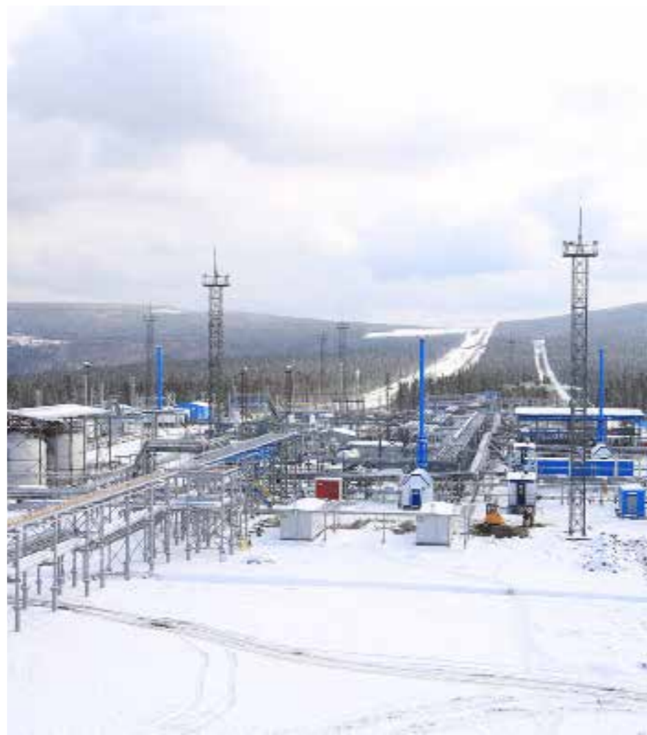
Установка подготовки газа УПГ-102 на Ковыктинском месторождении Источник: «Газпром»
