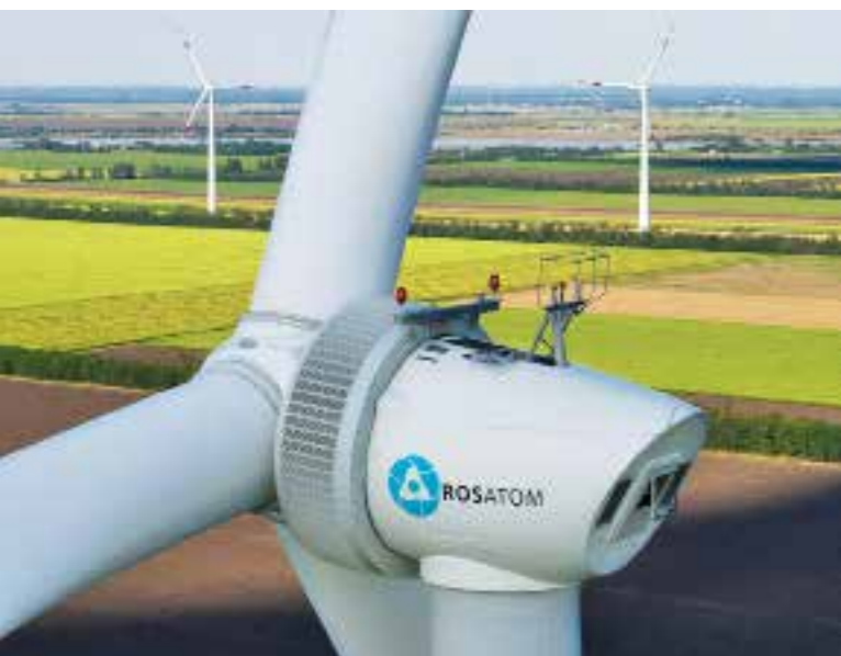
Адыгейская ВЭС Источник: Новавинд
