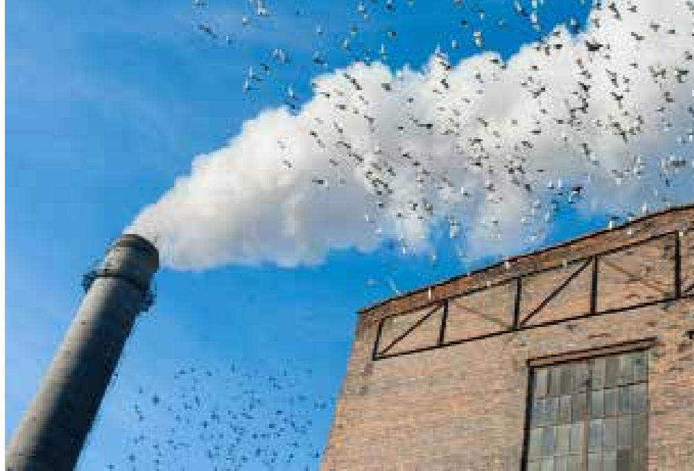
Котельная в Рубцовске
