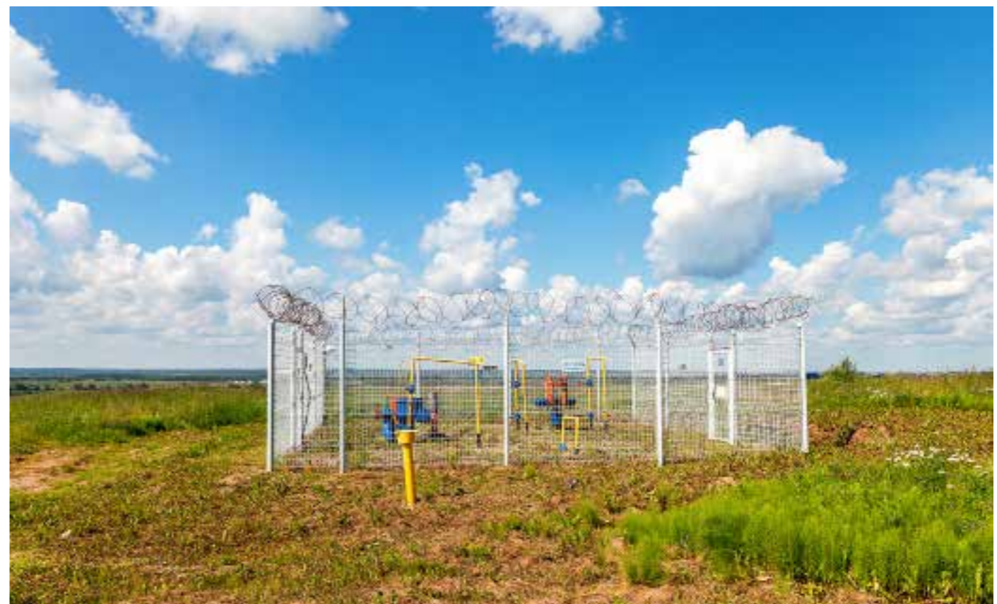
Газорегуляторный и газораспределительный пункт, ЦФО, Россия
