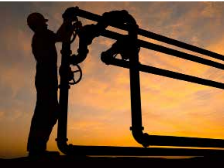
Отладка клапана межпоселкового газопровода Источник: Iurii / Depositphotos.com
