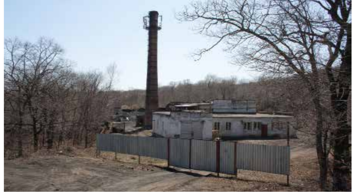
Котельная на острове Русский
