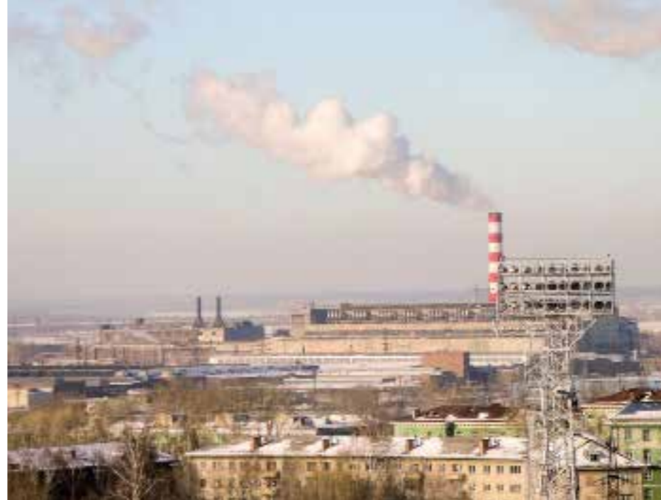
Новосибирская ТЭЦ Источник: energybase.ru
