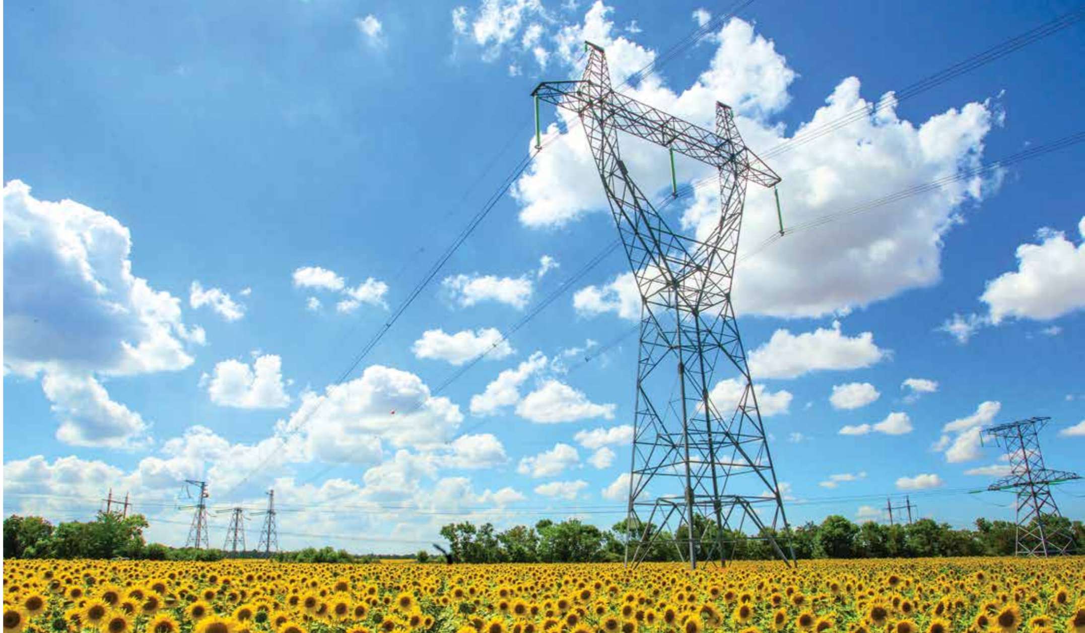
МЭС Юга_ВЛ 500 кВ Ростовская АЭС – Тихорецкая
