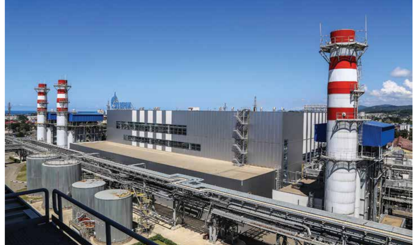
Адлерская ТЭС 367 МВт
