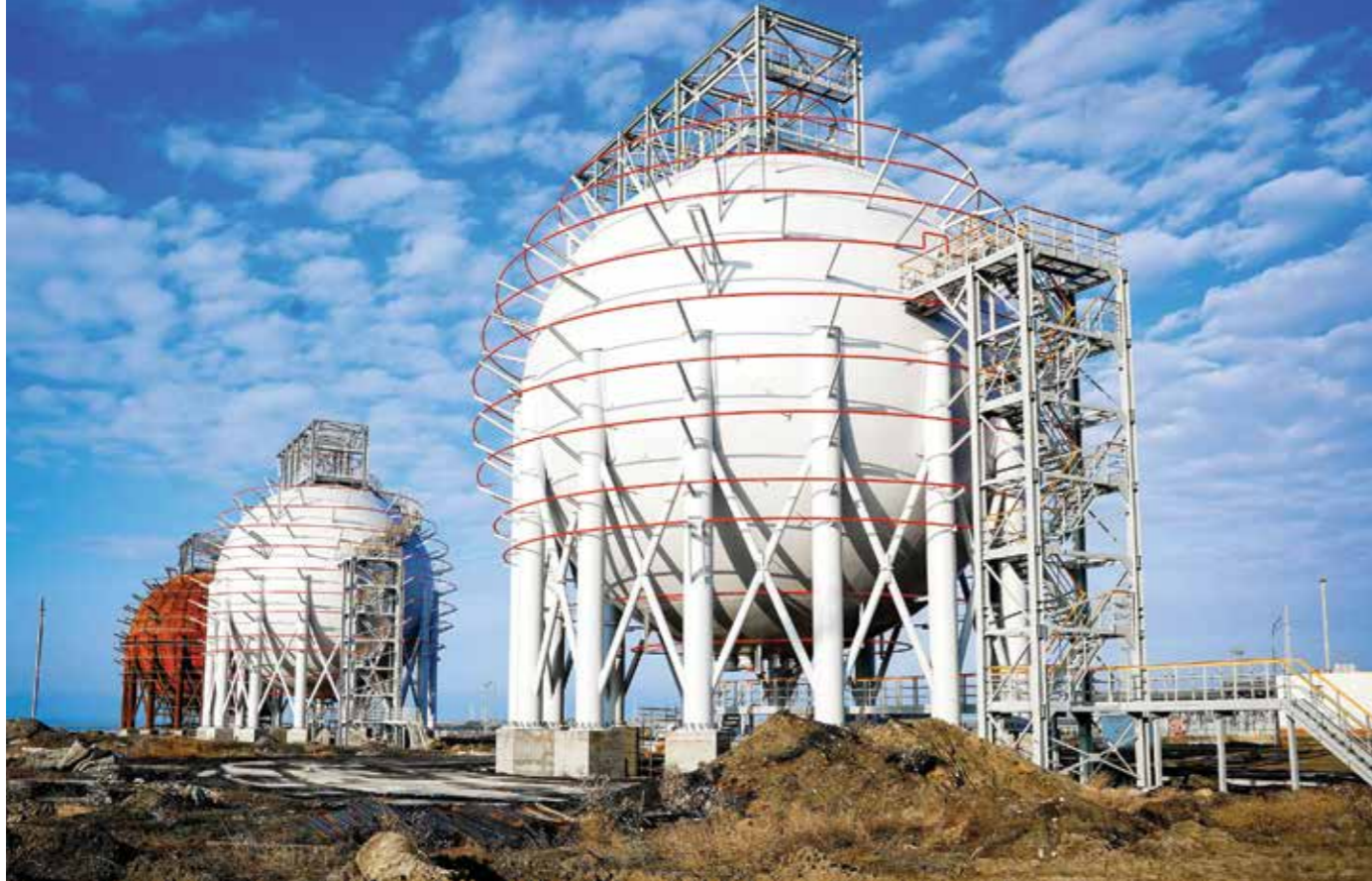
Шаровые резервуары используются для хранения жидкого водорода
