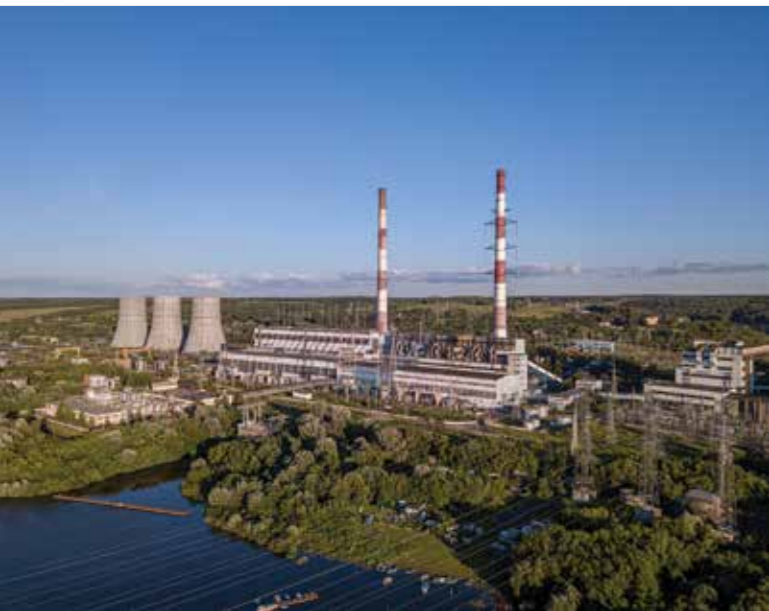
Каширская ГРЭС Источник: «Интер РАО»
