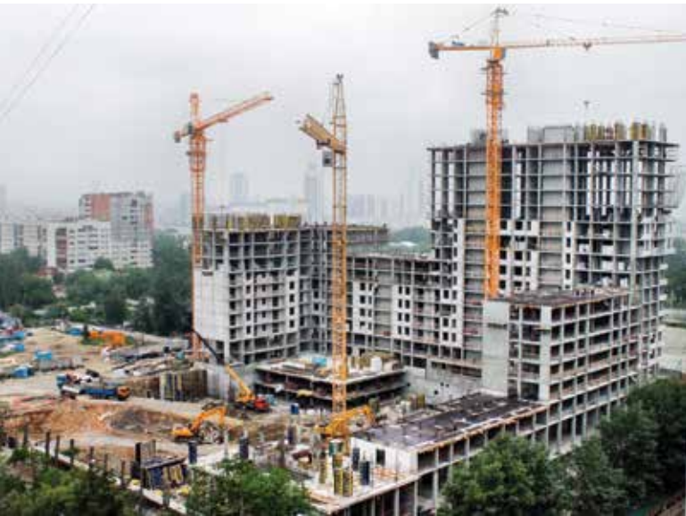
Строительство жилого комплекса
