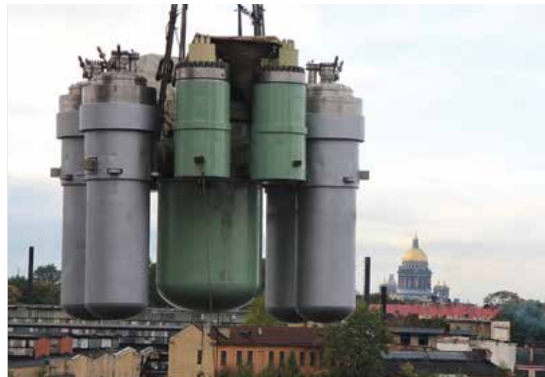
Установка парогенерирующего блока (ПГБ) ядерной энергетической установки КЛТ-40С Источник: «Росатом»
