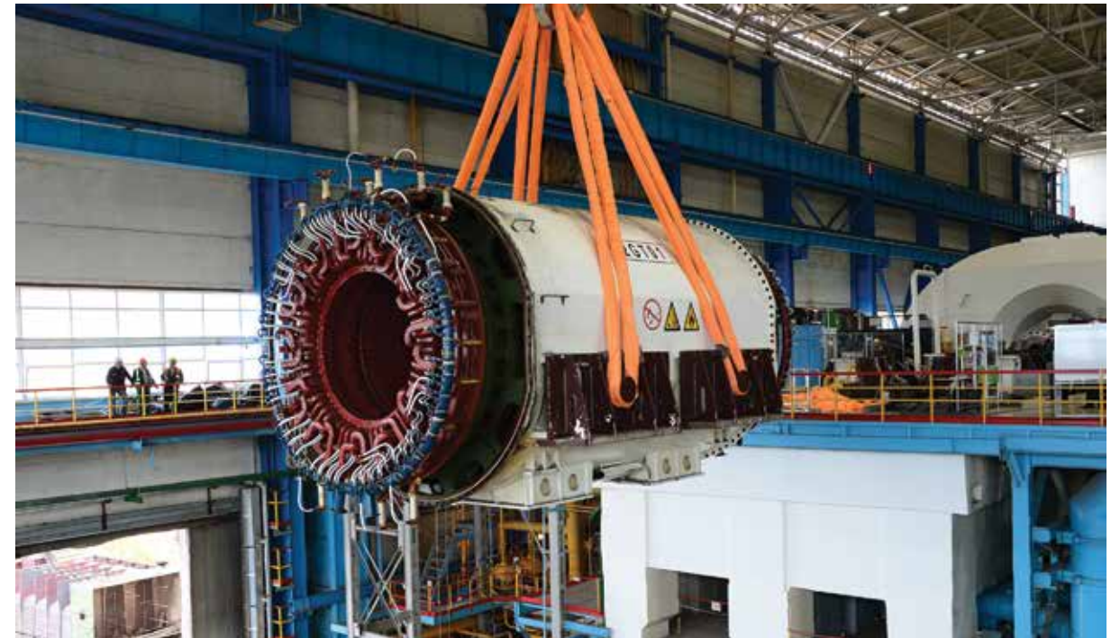
Замена генератора, Балаковская АЭС
