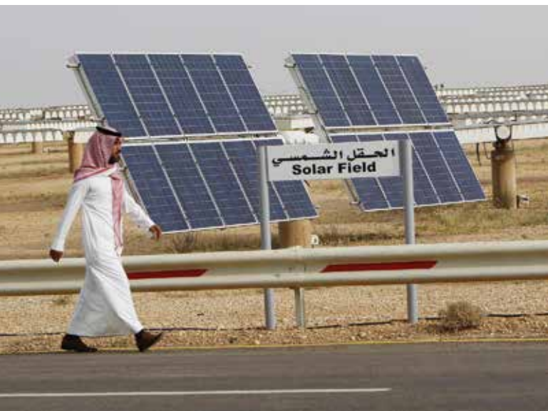
Солнечная электростанция в г. Саккака, Саудовская Аравия Источник: энергосми.ру
