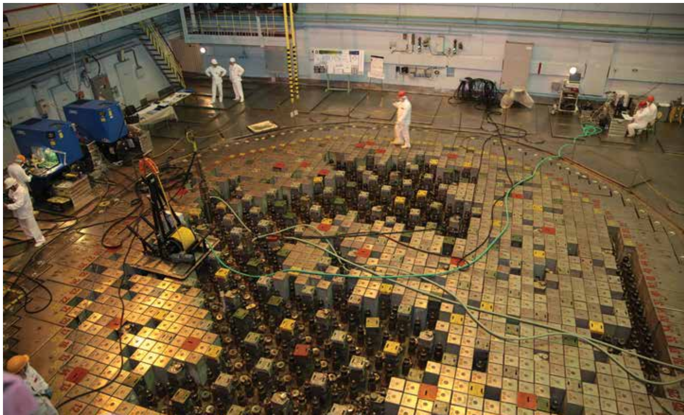
Ремонт графитовой кладки РБМК, Курская АЭС
