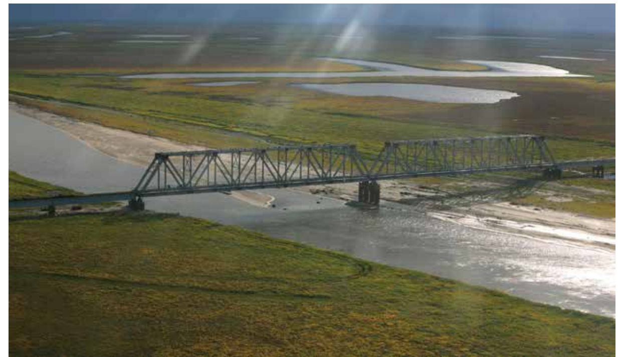
Мост через реку Юрибей
