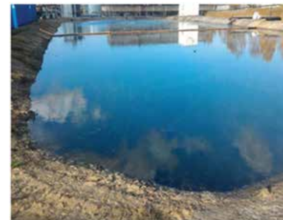
Рис. 2. Внешний вид ШО № 1 по состоянию на 16.10.2019 г.
