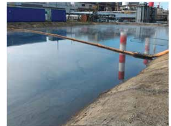
Рис. 3. Внешний вид ШО № 1 по состоянию на 16.10.2019 г.
