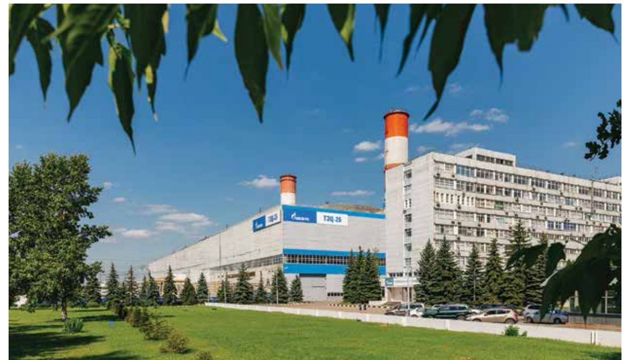
ТЭЦ-26, ПАО «Мосэнерго»
