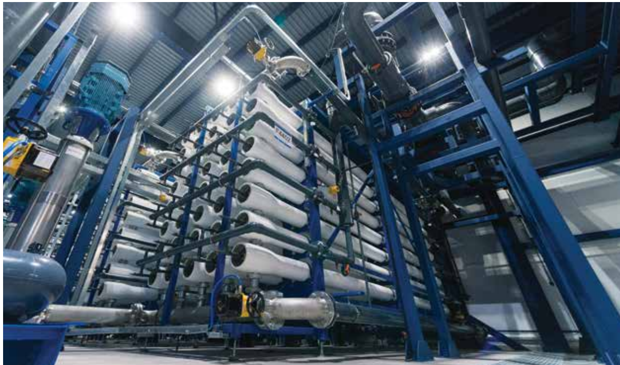
Очистные сооружения Московского НПЗ
