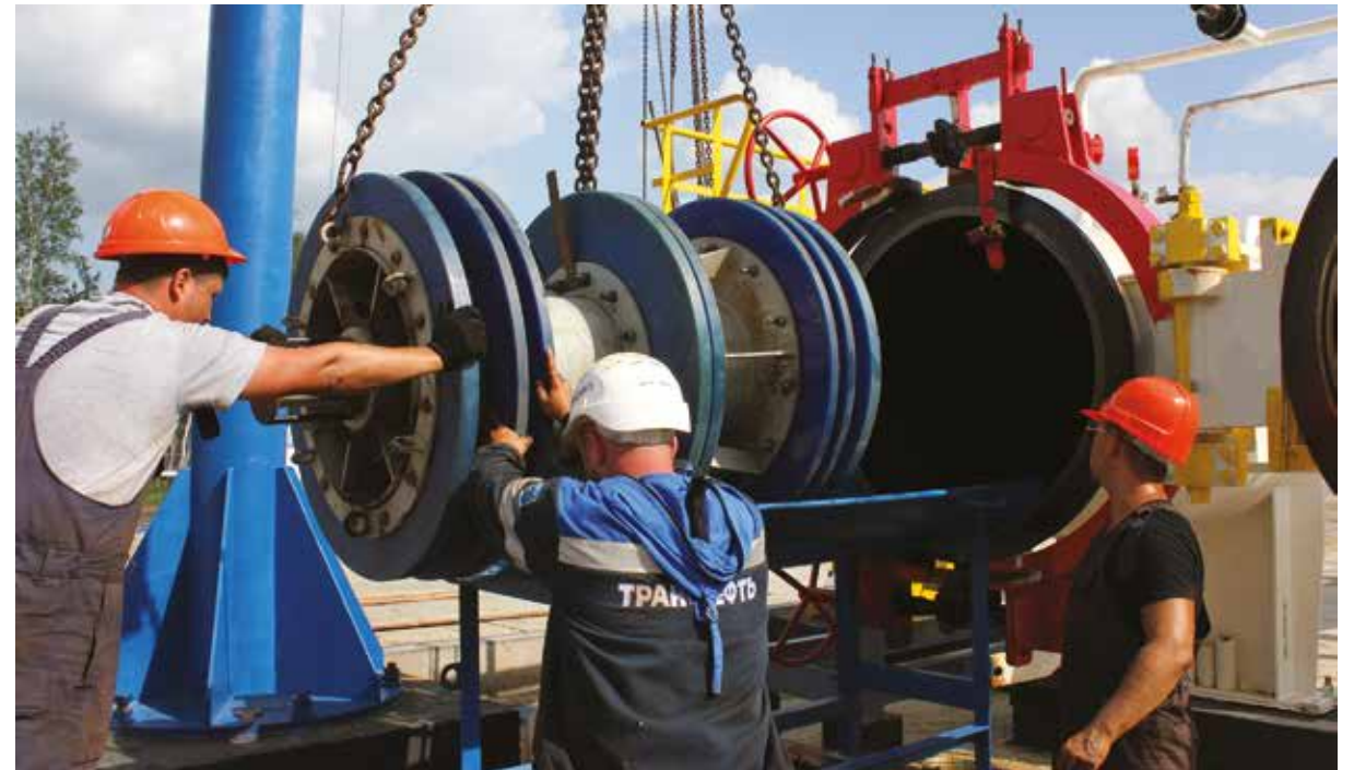
Строительные работы на объектах «Транснефти»
