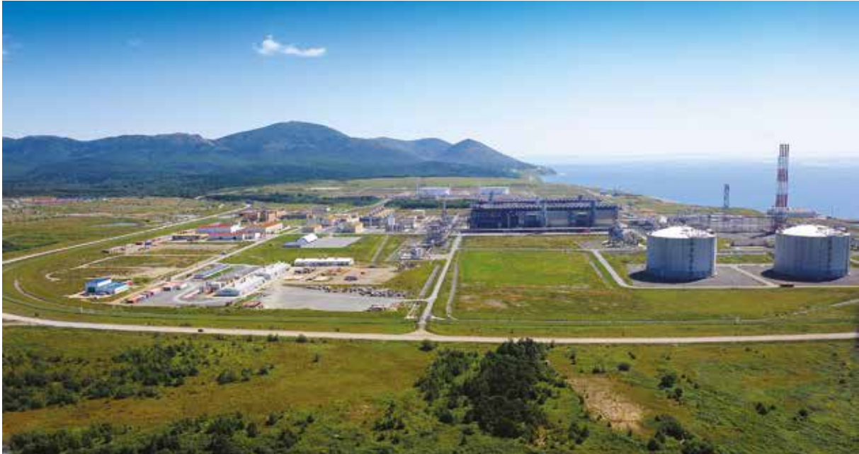
СПГ-завод проекта «Сахалин-2» Источник: gazprom.ru
