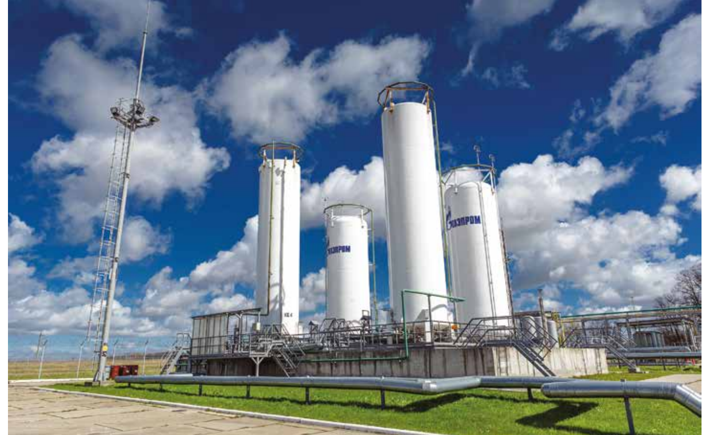
Завод малотоннажного СПГ
