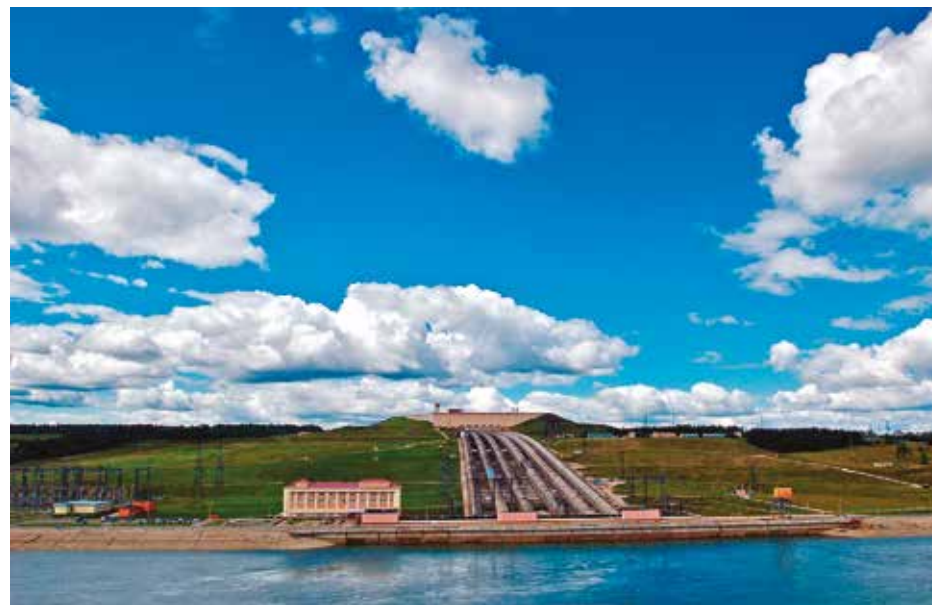
Загорская ГЭС-ГАЭС Источник: zagaes.rushydro.ru
