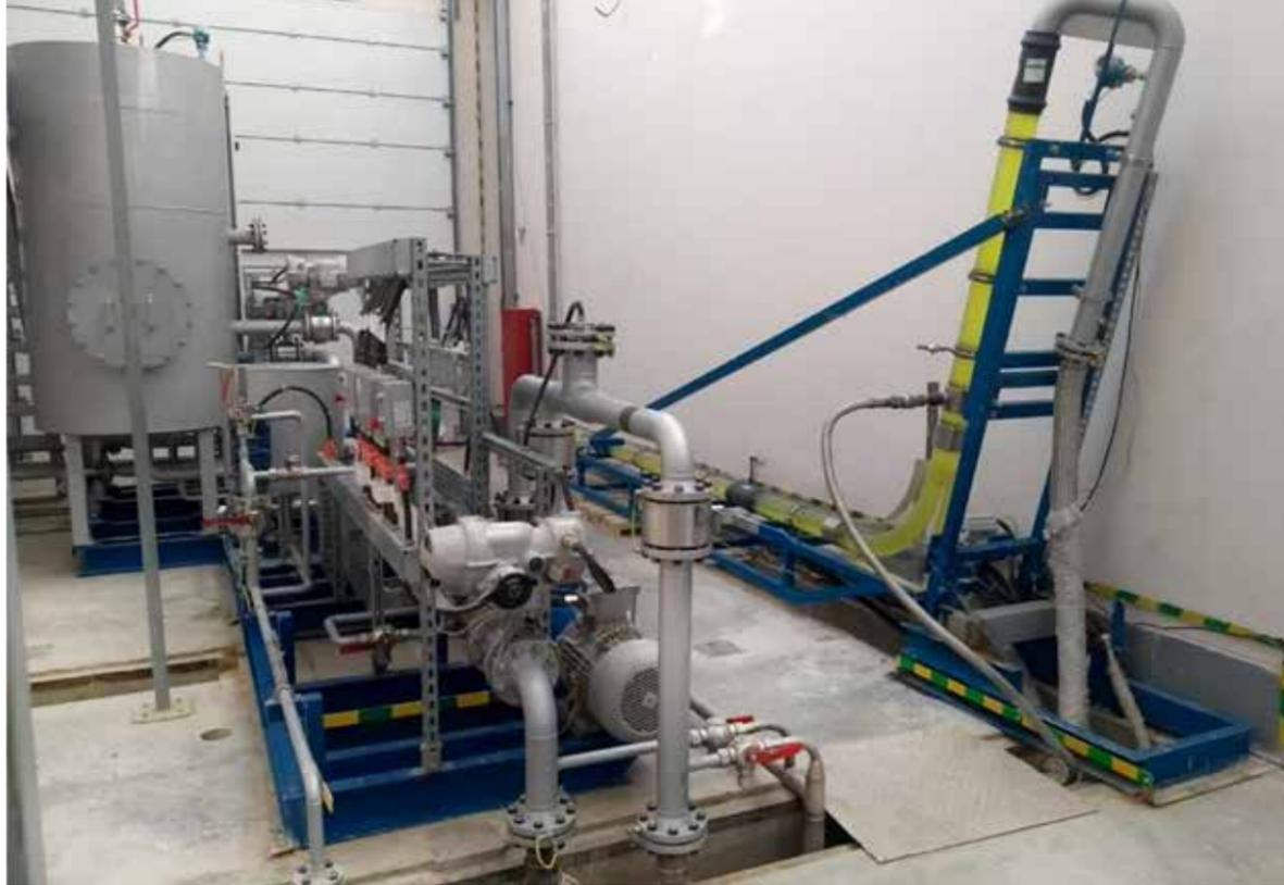
Рис. 3. Внешний вид блока накопления и выноса воды
