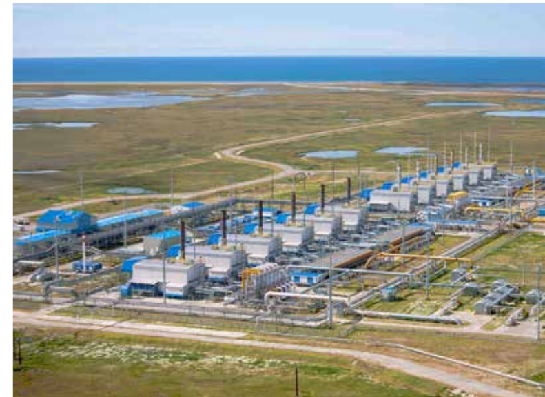
ГКС Байдарацкая газопровода Бованенково Ухта Источник: «Газпром»
