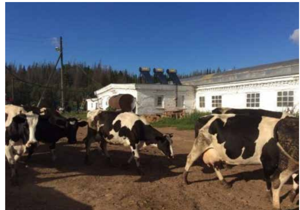
Примечание: солнечный водонагреватель (2 вакуумных и 24 трубчатых коллектора) обеспечил снижение затрат на электроэнергию для подогрева воды
