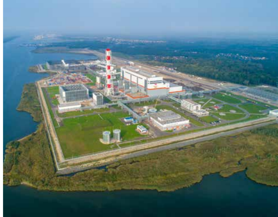
Приморская ТЭС, Калининградская область Источник: www.utz.ru
