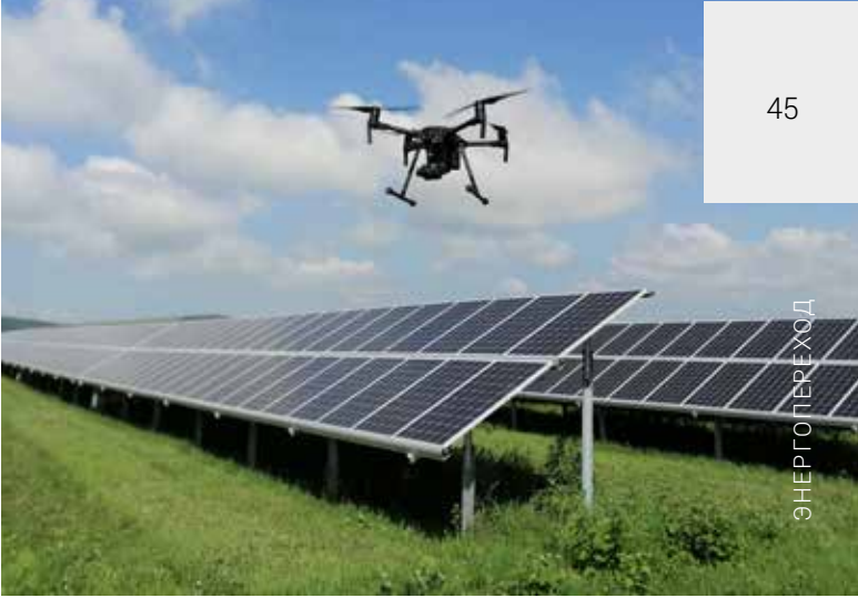
Солнечная электростанция, Лисья Нора Источник: «Хевел»
