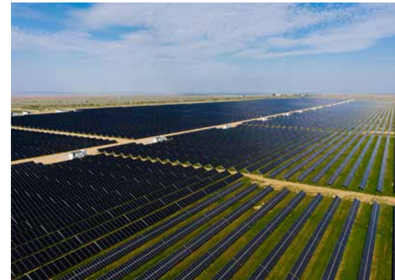
Аршанская СЭС Источник: bigpowernews.ru
