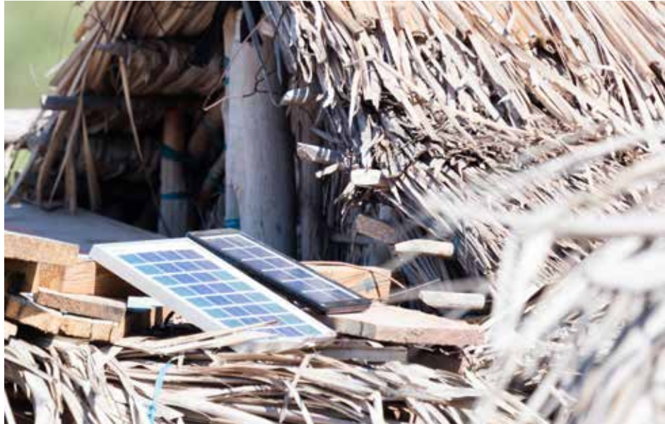
Солнечные панели на крыше африканской хижины Источник: michaklootwijk / depositphotos.com
