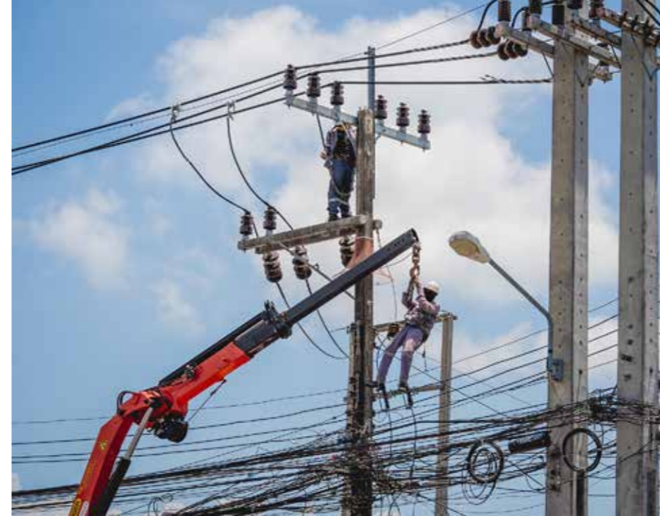
Аварийные работы по ремонту ЛЭП Источник: depositphotos.com
