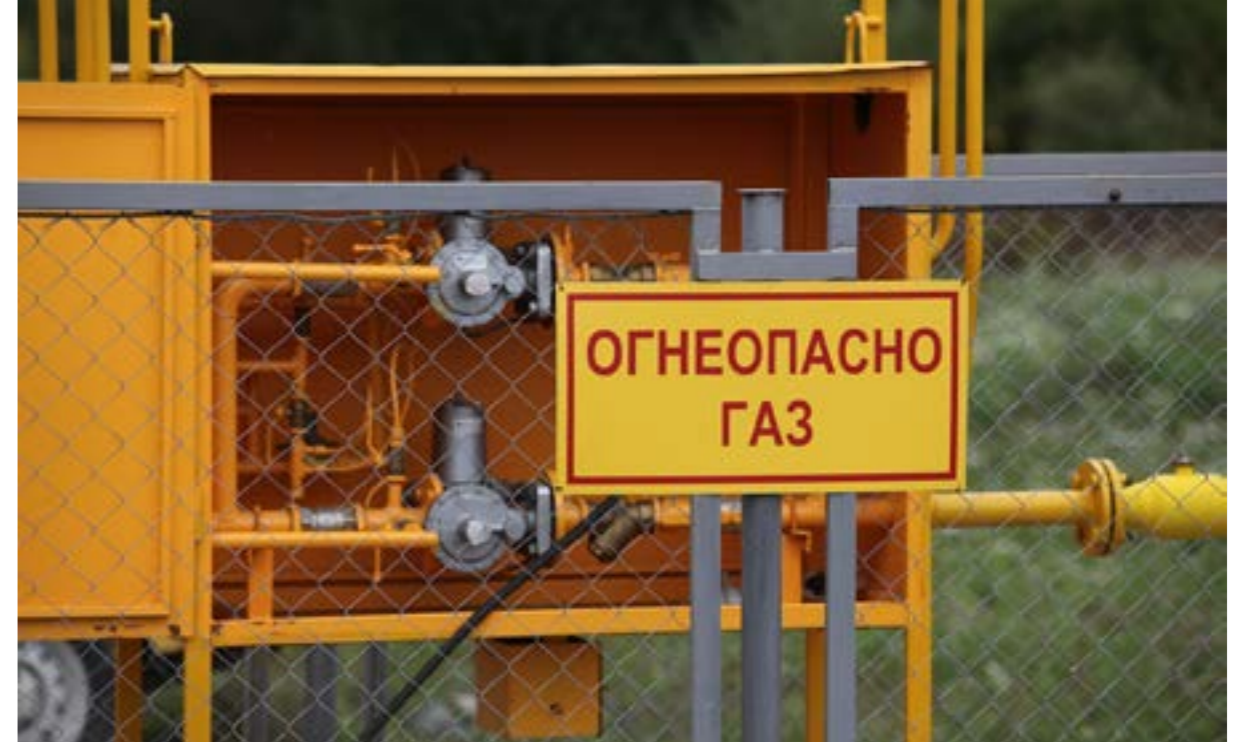
Подключение участков к межпоселковым газопроводам
