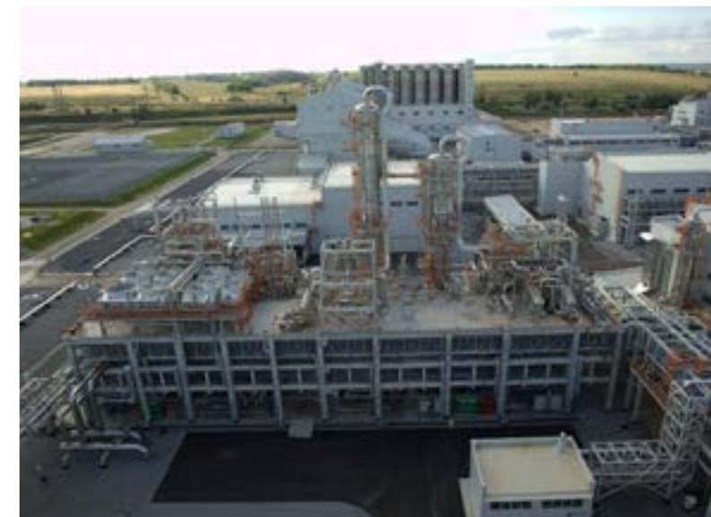
Производство ООО «РусВинил» Источник: «Сибур Холдинг»
