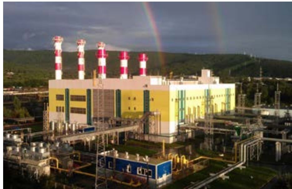
ТЭЦ в Южно-Сахалинске Источник: sakhalinenergo.ru
