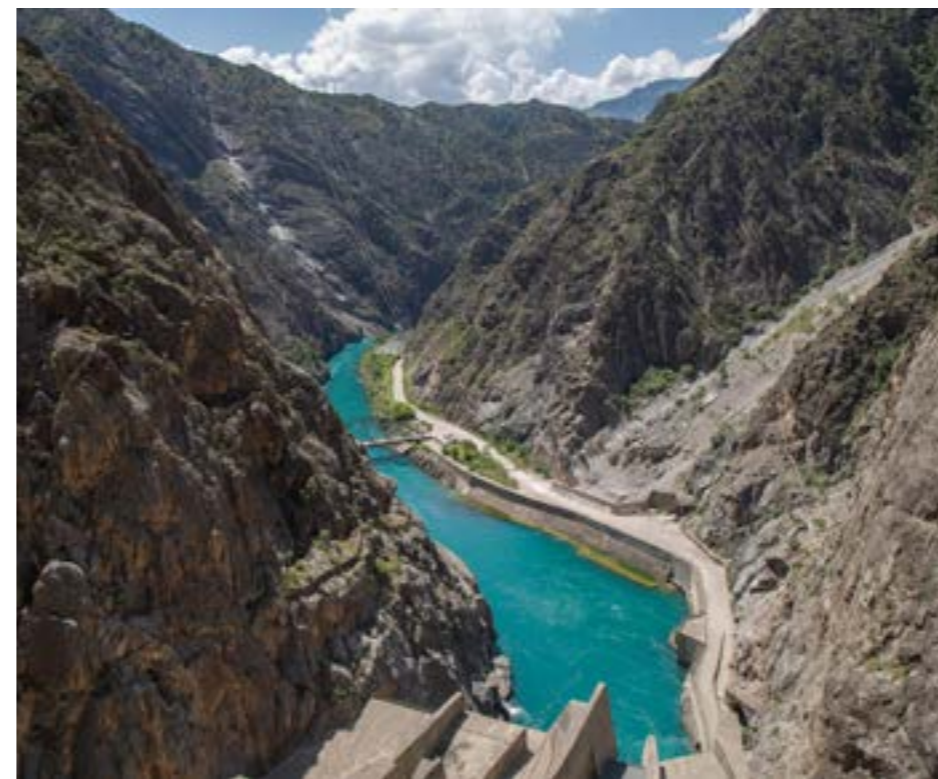
Токтогульская ГЭС Источник: trip-for-the-soul.ru
