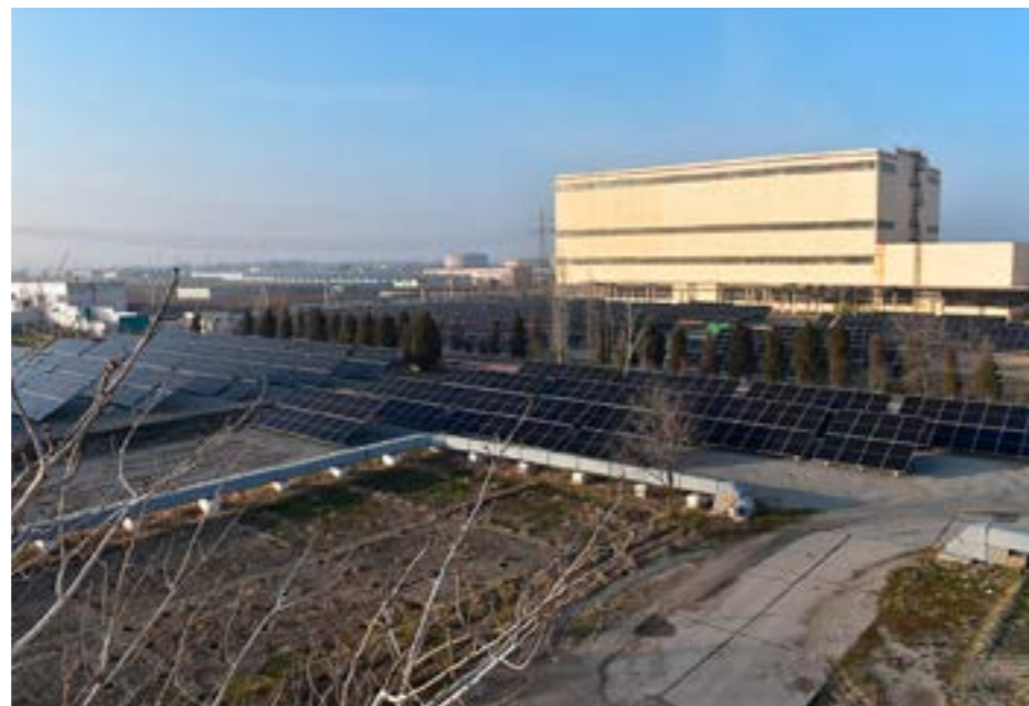
Сырдарьинская ТЭС Источник: minenergy.uz
