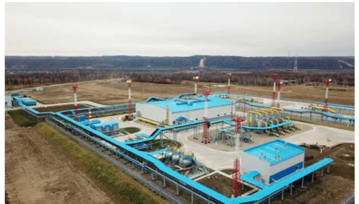
Газопровод «Сила Сибири»
