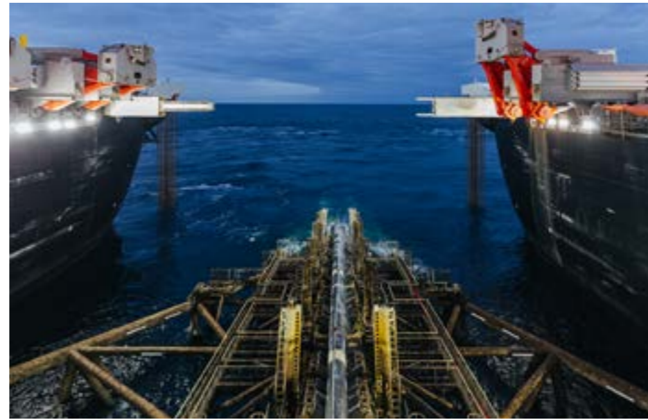
Укладка газопровода «Турецкий поток» Источник: «Газпром»
