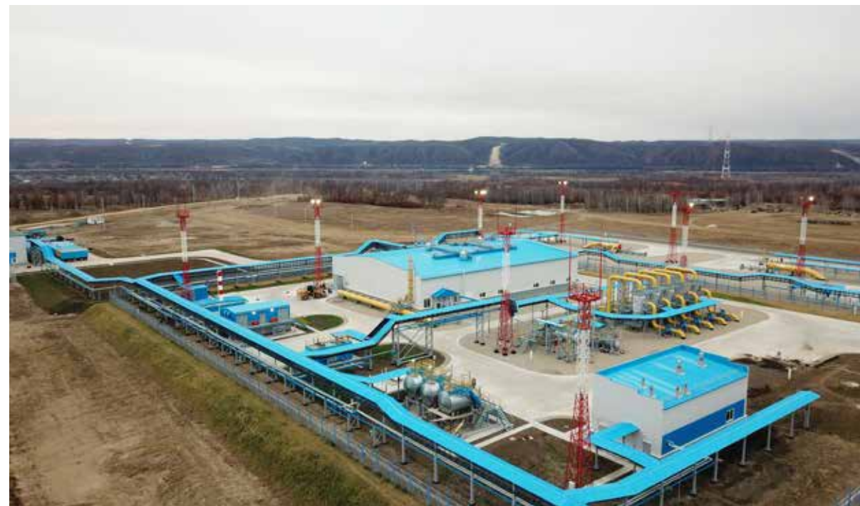
Газопровод «Сила Сибири»
