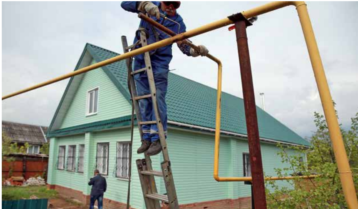
Врезка в центральный газопровод для подключения жилого дома
