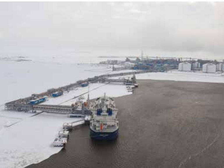
«Ямал СПГ» Источник: «НОВАТЭК»
