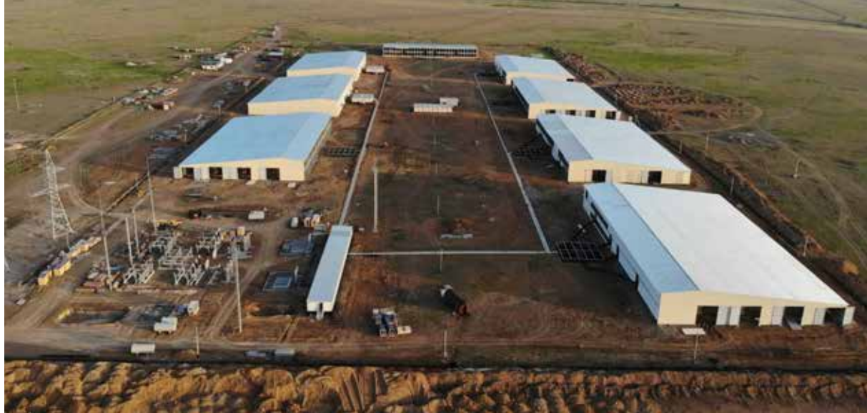
Строительство новой майнинг-фермы в Казахстане
