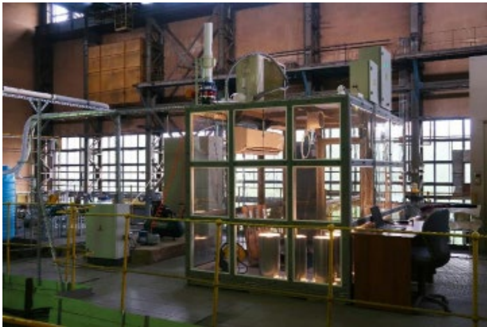
Рис. 2. Общий вид газовой камеры с размещенными в ней ФБР и местом оператора (справа). Слева вне камеры расположены элементы системы подготовки дымовых газов
