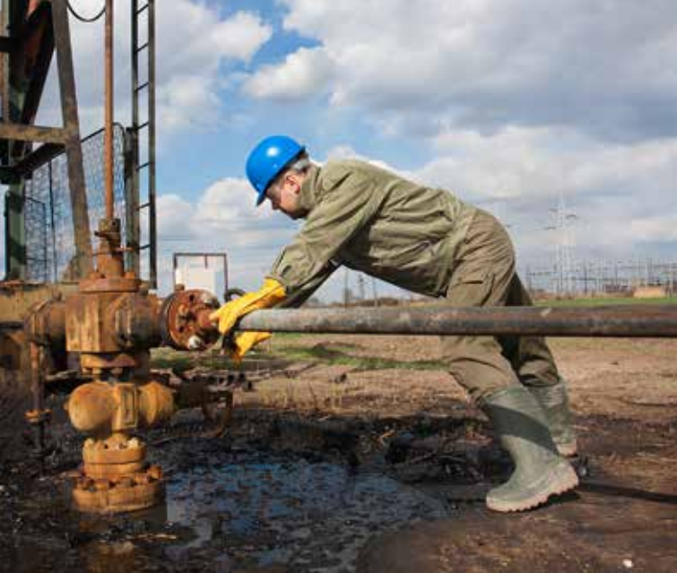
Цементирование скважин Источник: 1svoimi-rukami.ru
