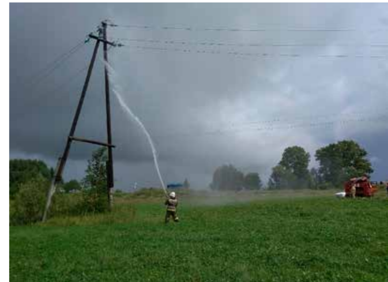
Авария на ЛЭП в Марий Эл Источник: gtrkmariel.ru
