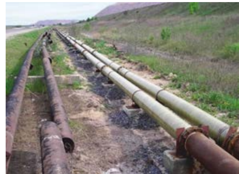
Рис. 1. Замена изношенных корродированных стальных труб на композитные
