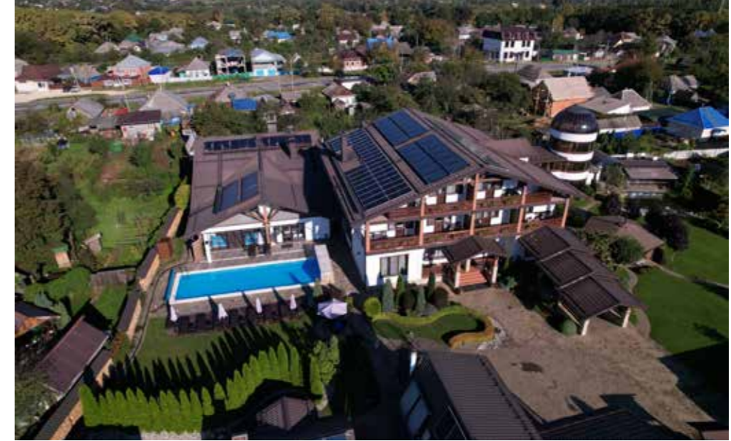
Рис. 8. Гелиоустановка с СК АО «ВПК НПО «Машиностроение» и ООО «Vist Energy» отеля «Усадьба Парфенова» в Адыгее
