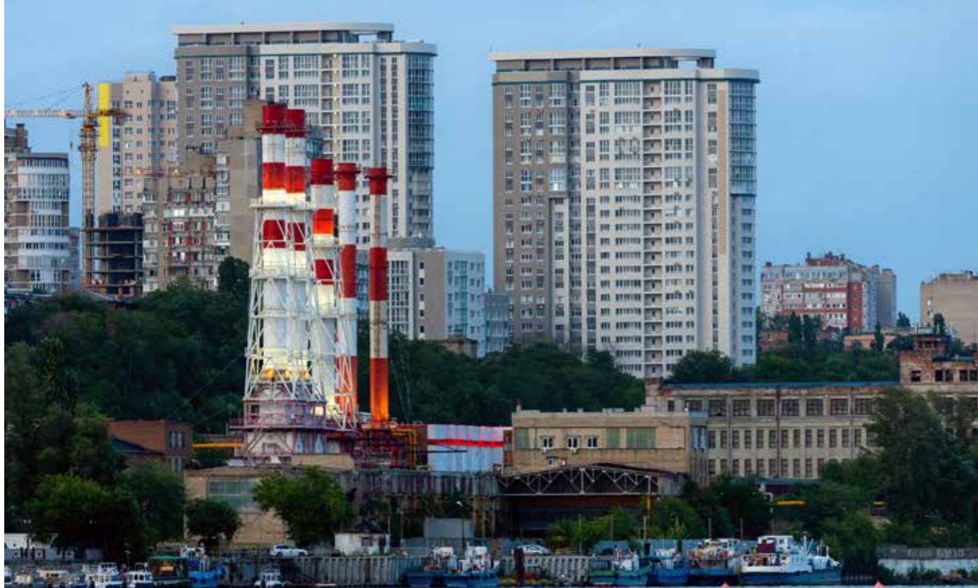
Дымоходы современной котельной
