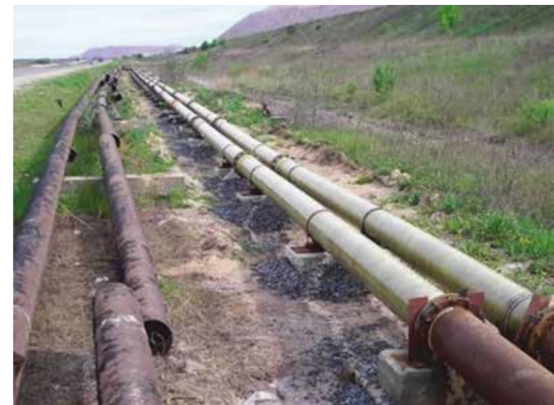
Рис. 1. Замена изношенных корродированных стальных труб на композитные
