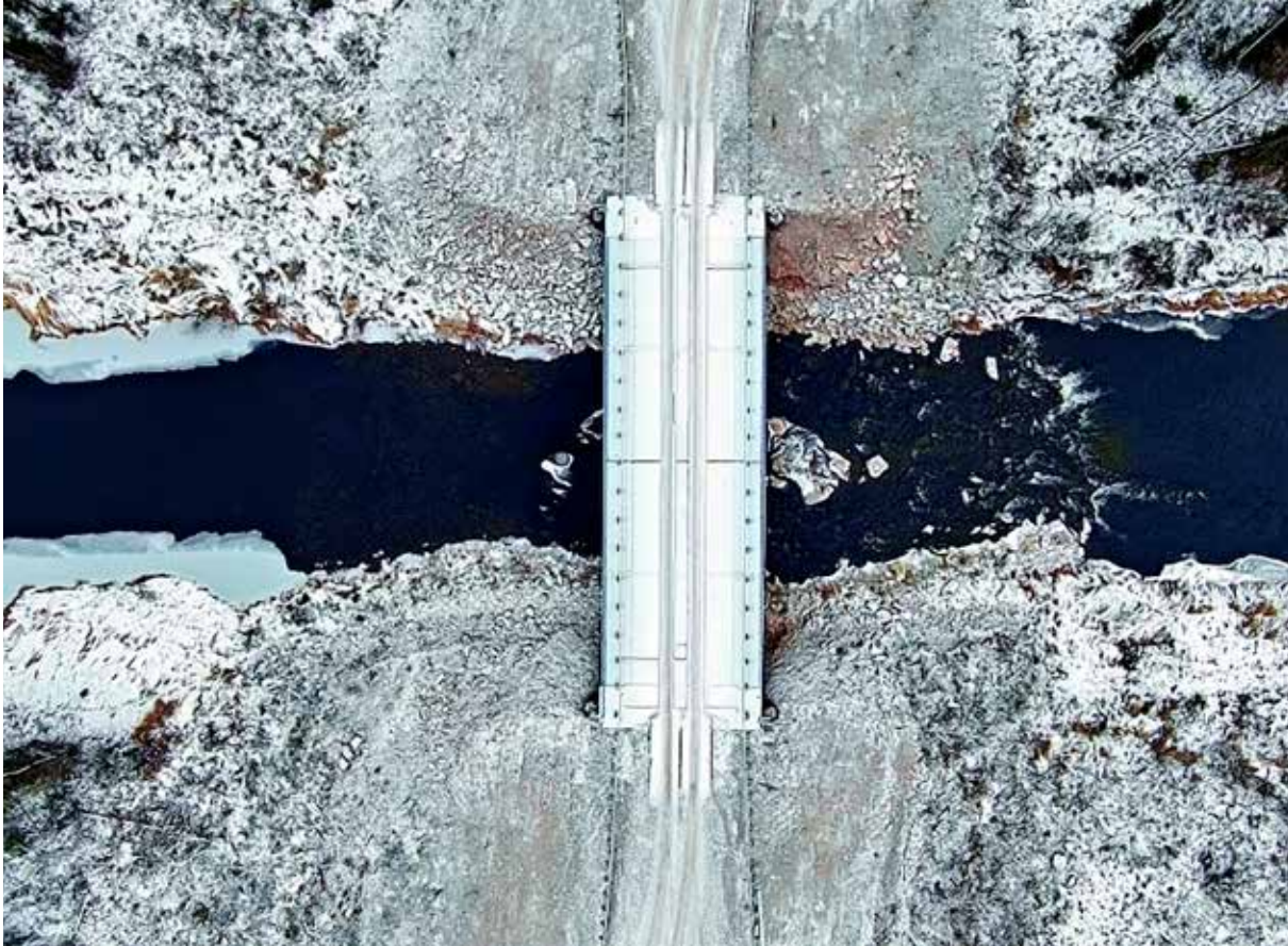
Вдольтрассовый проезд ТС-ВСТО
