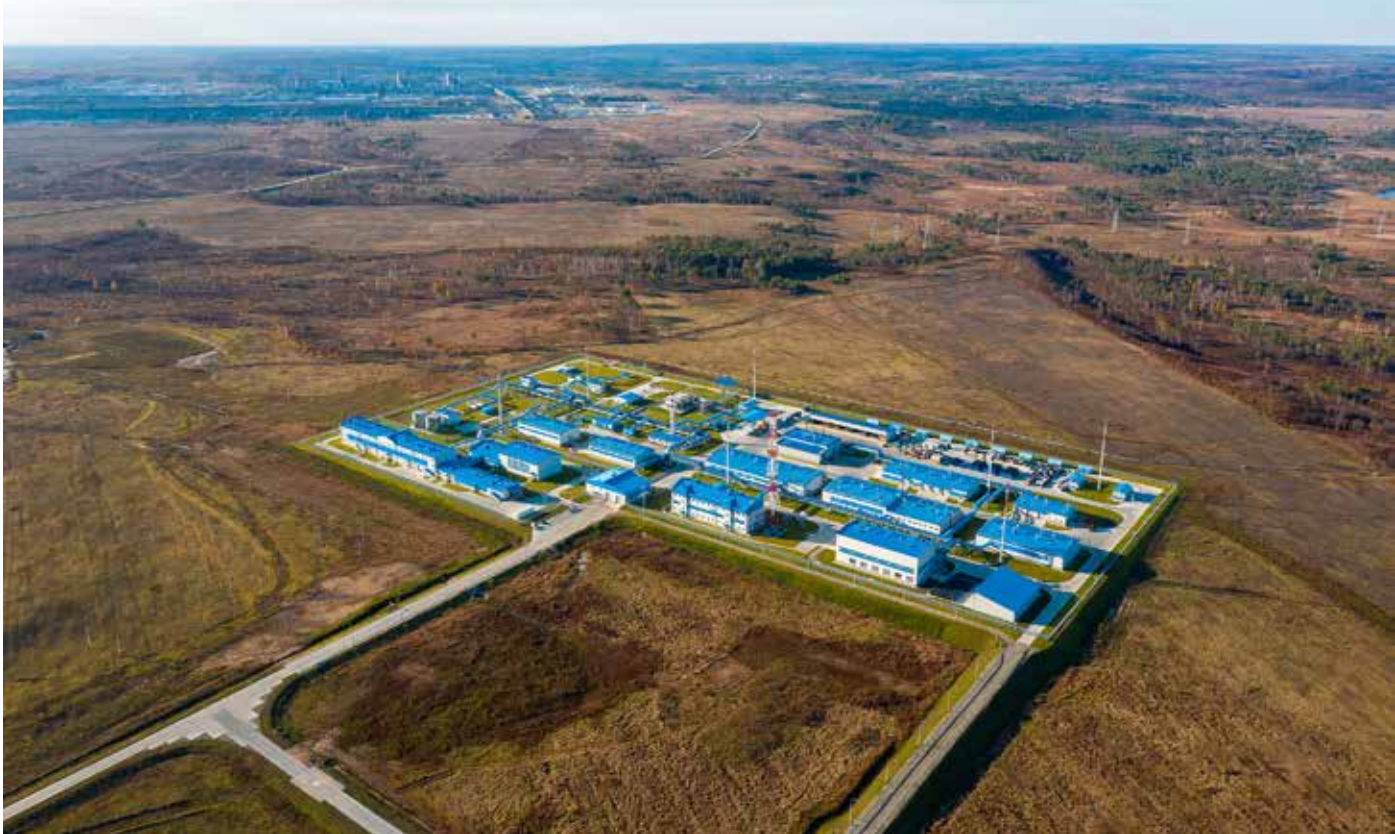
Газопровод «Сила Сибири»
