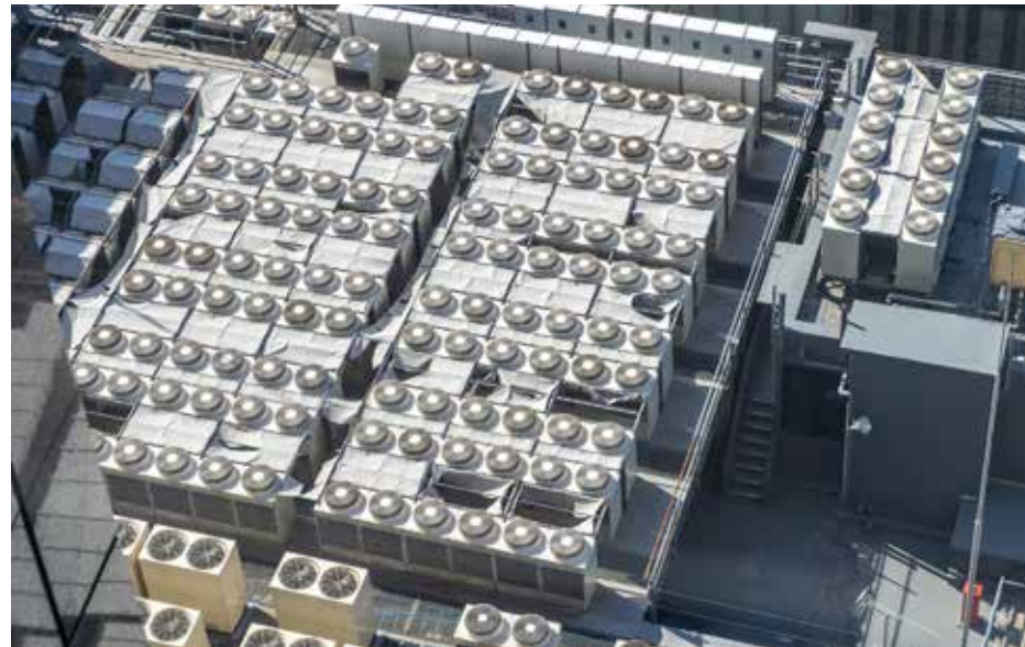
Охлаждение на производстве Источник: TakerWalker / depositphotos.com
