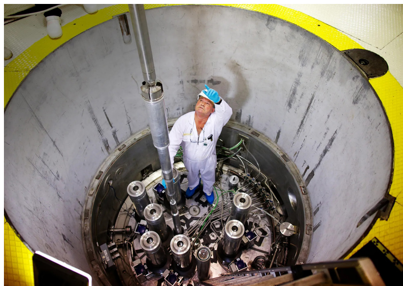
Ремонт реактора РТ-760
