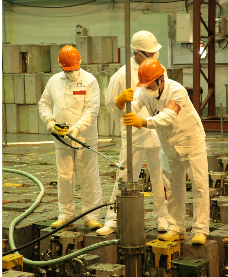
Ремонт графитовой кладки на Курской АЭС Источник: «Росатом»
