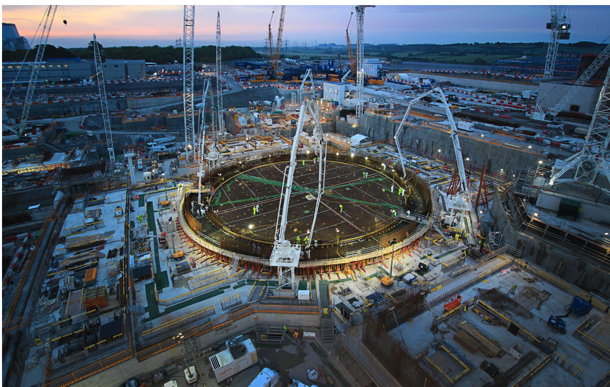
Строительство АЭС «Хинкли-поинт»
