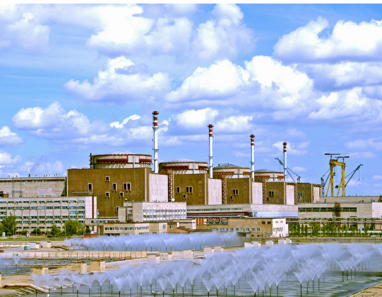
Балаковская АЭС Источник: «Росэнергоатом»
