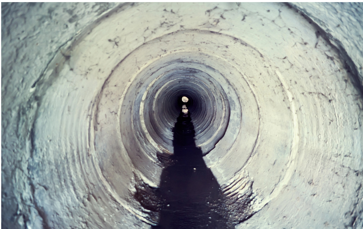
Поток воды в трубопроводе
