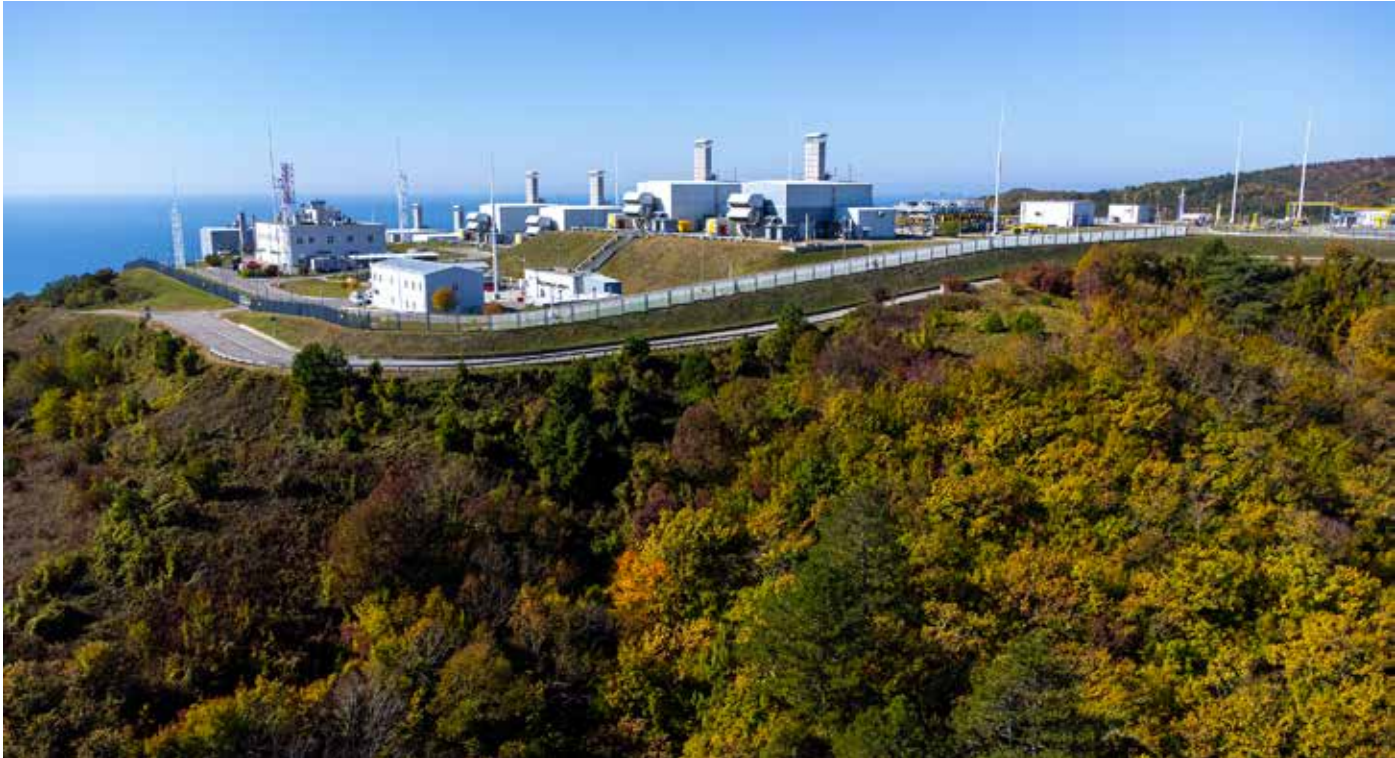
Компрессорная станция Береговая газопровода «Голубой поток»
