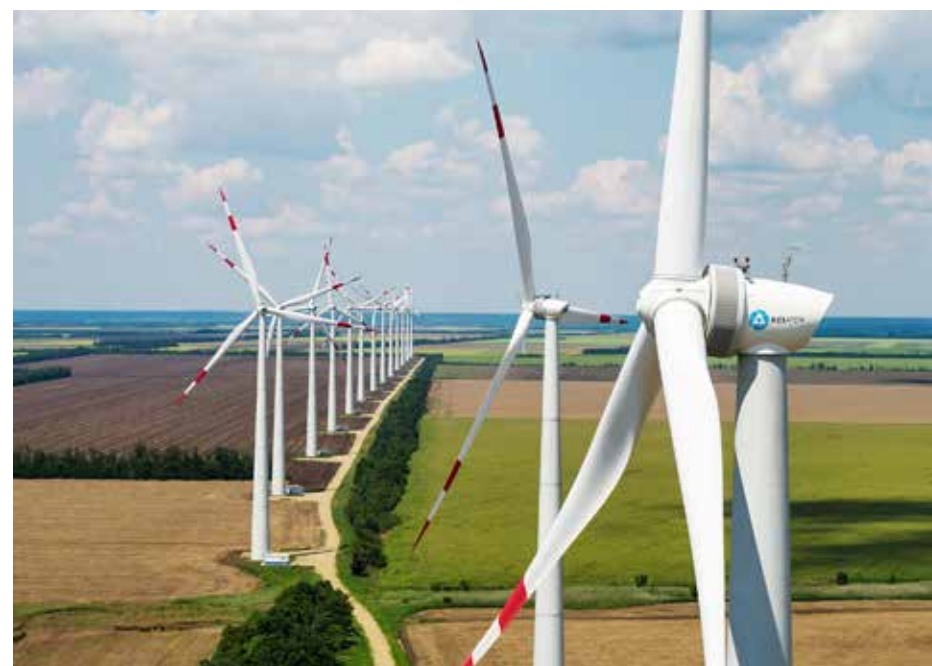
Адыгейская ВЭС Источник: «НоваВинд»
