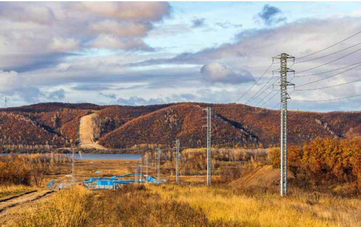
Газопровод «Сила Сибири»
