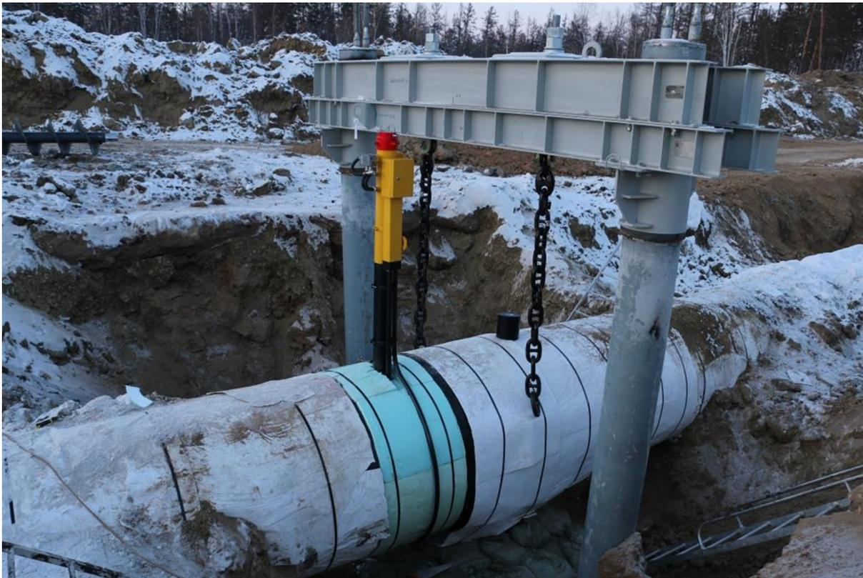
Рис. 4. Участок магистрального нефтепровода, расположенный подземно на подвесных опорах
