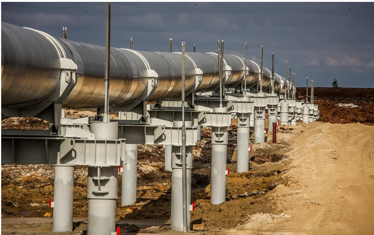
Рис. 2. Участок магистрального нефтепровода, расположенный надземно на опорах
