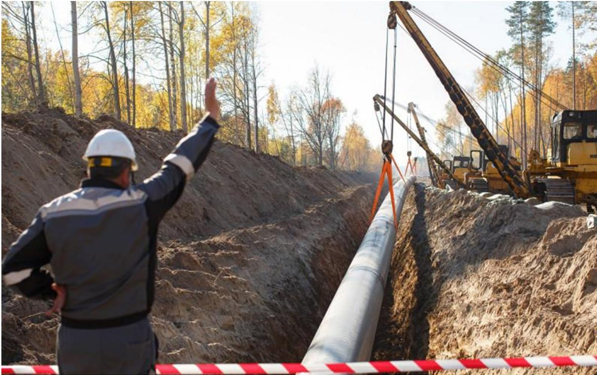
Рис. 3. Участок магистрального нефтепровода, расположенный подземно с опиранием на грунт
