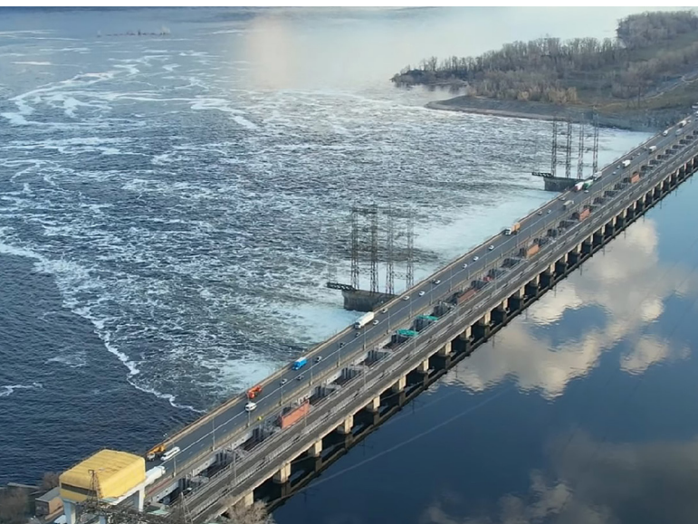
Жигулевская ГЭС Источник: tvsamara.ru
