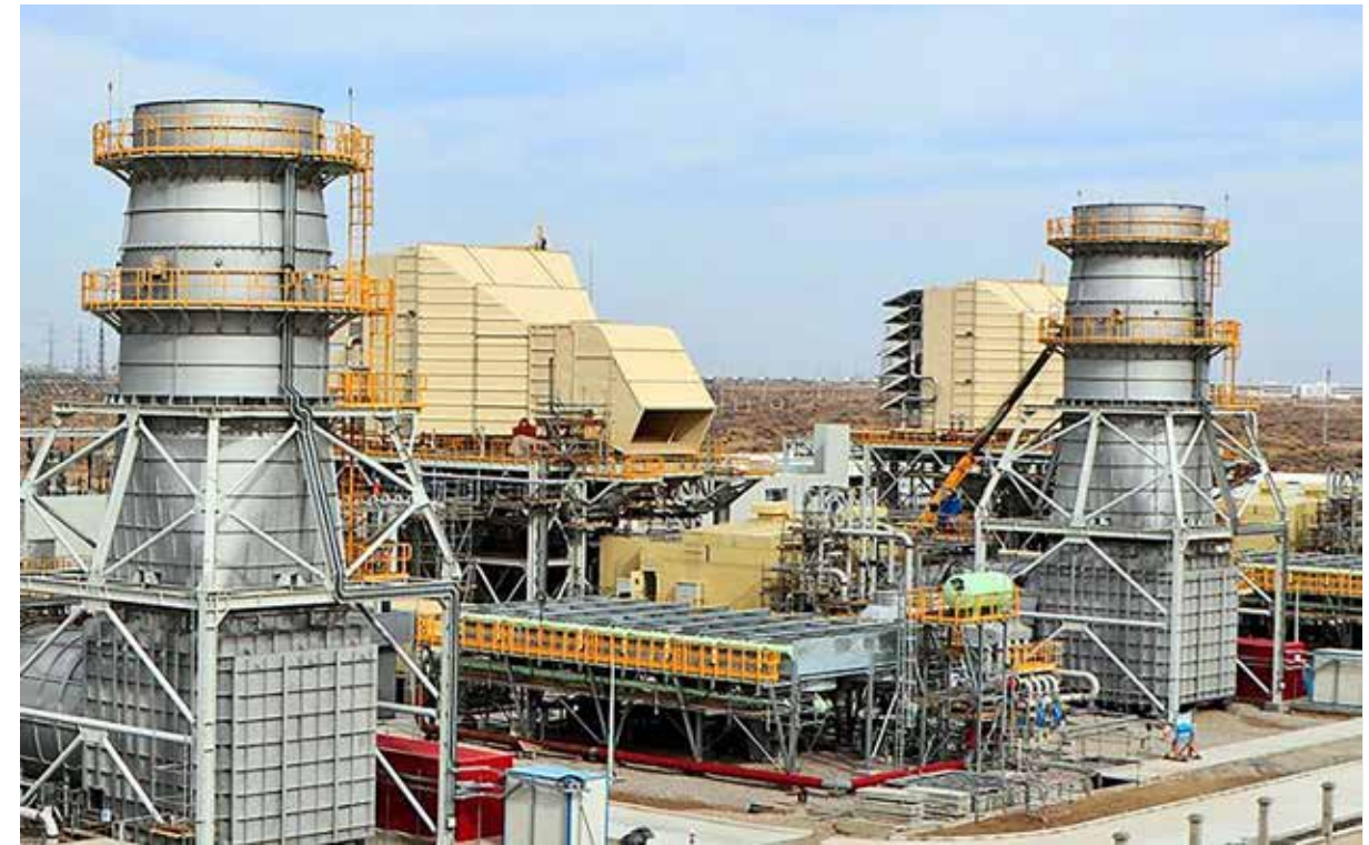
Дашогузская ГЭС, Туркменистан
