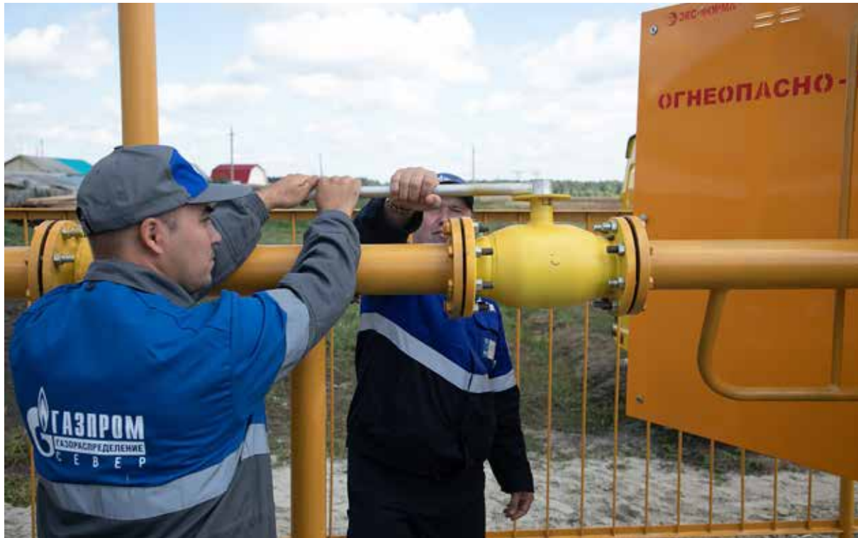
Пуск газа в деревне Пономарева Заводоуковского городского округа Тюменской области
