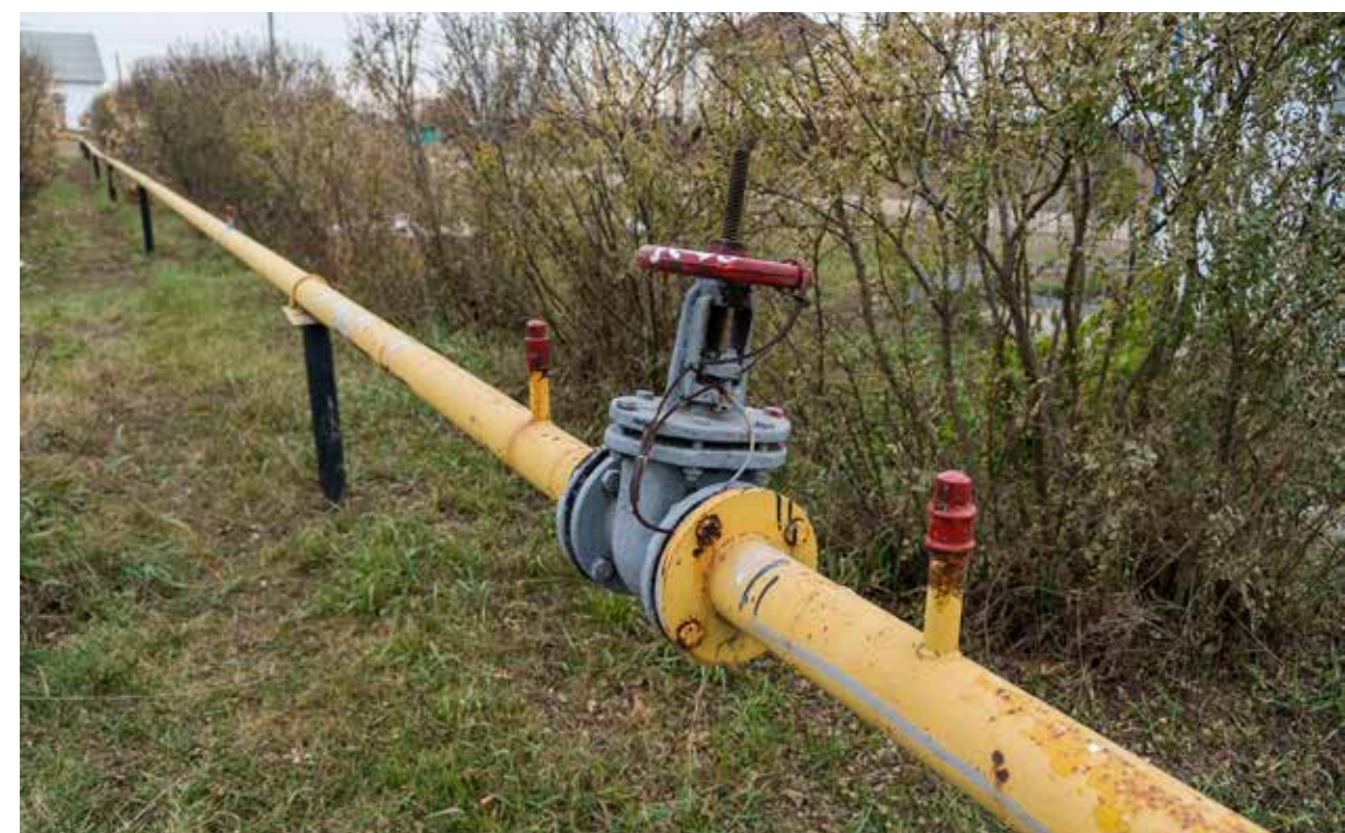
Межпоселковый газопровод
