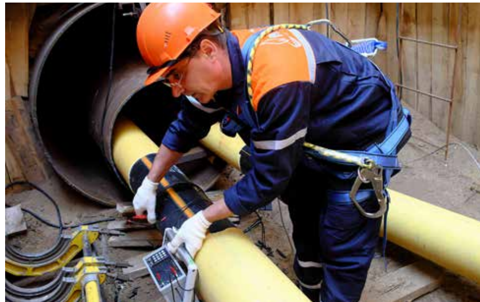
Укладка межпоселкового газопровода Источник: kasheloff.ru
