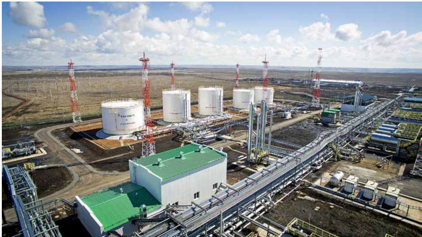
Добыча сверхвязкой нефти на Ашальчинском месторождении
