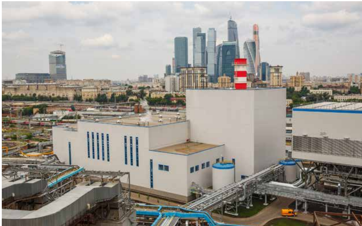
Энергоблок ПГУ-220 ТЭЦ-12 ОАО «Мосэнерго»
