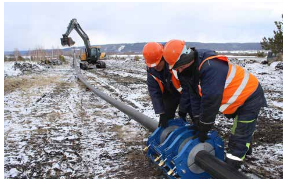
Укладка межпоселкового газопровода в Ульяновской области Источник: «Газпром»
