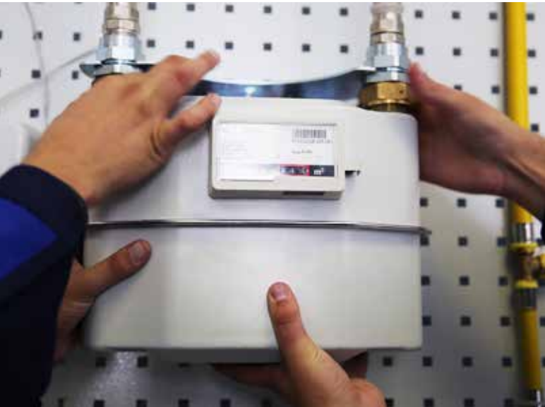
Установка газового счетчика Источник: АО «Ставропольгоргаз»
