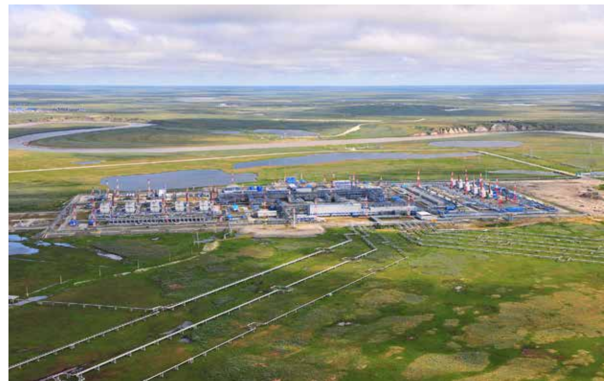
Газовый промысел № 1 Бованенковского месторождения
