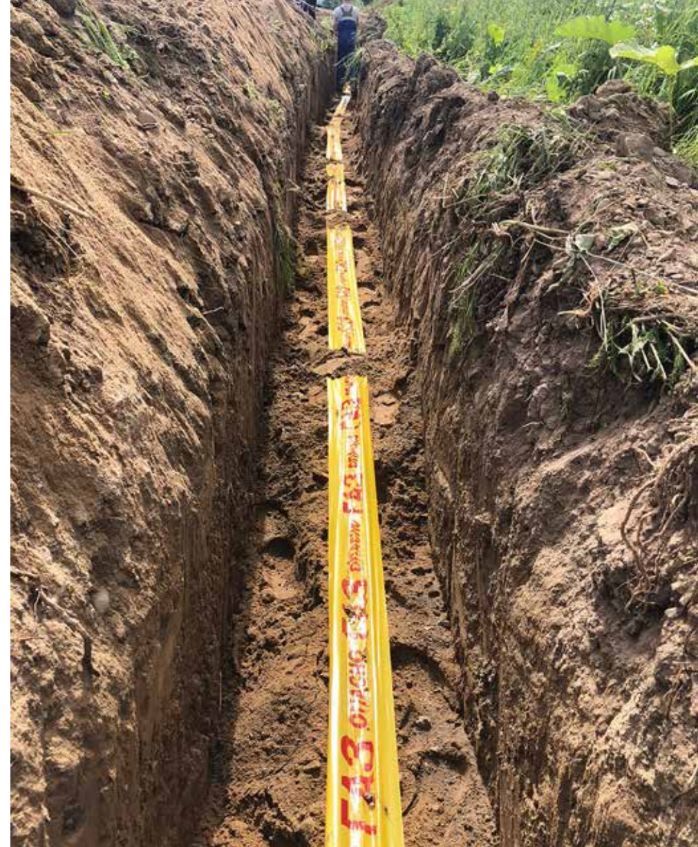
Укладка межпоселкового газопровода в Ломоносовском районе, Ленинградская область
